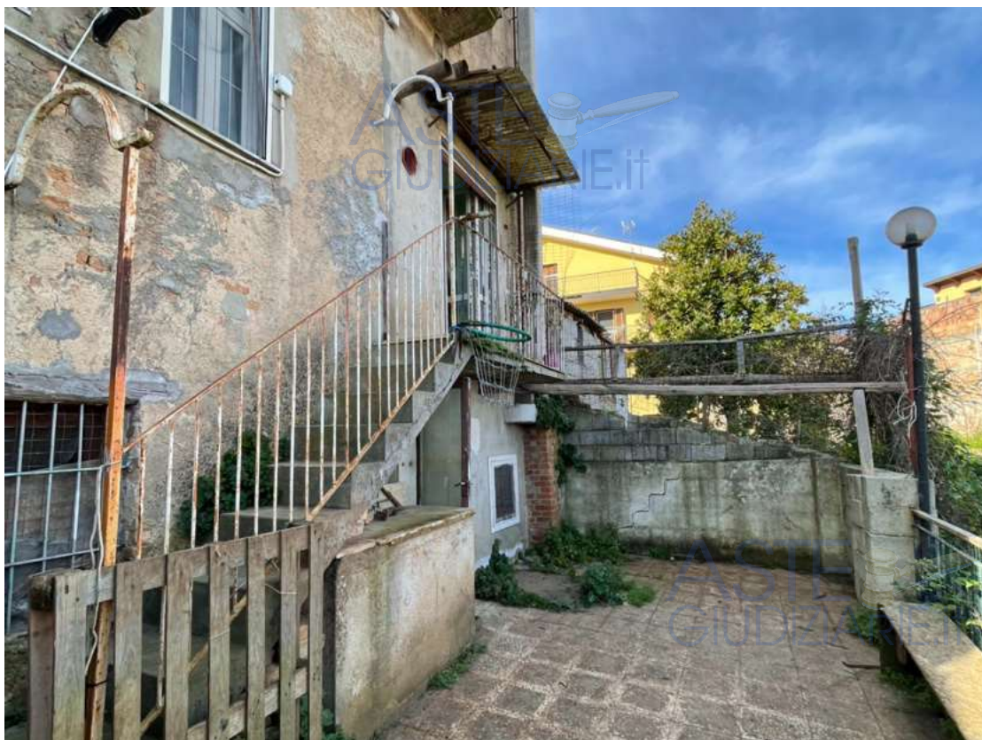
Foto 10 N.C.E.U. Sant'Onofrio fg. 6 - p.lla 724 sub 2 cortile
