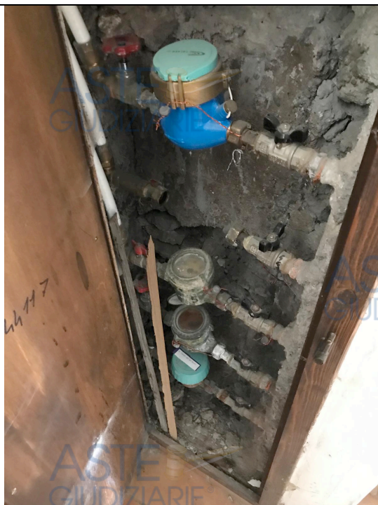
Vani contatori utenze posti nell'androne condominiale a servizio delle unità immobiliari
