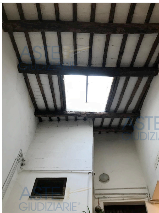
Vano scala condominiale
