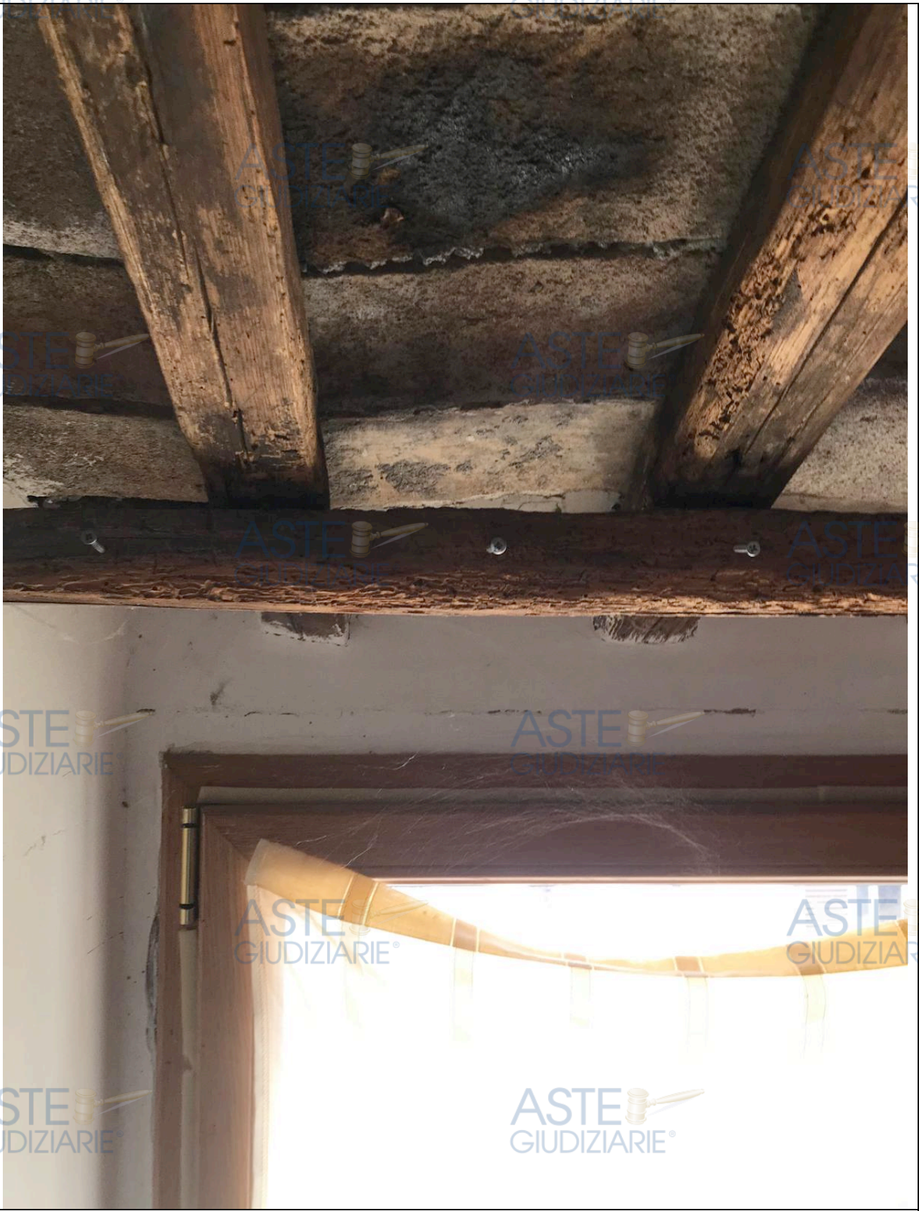
Particolare copertura interna (struttura) del vano 1
