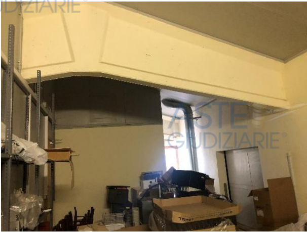
Magazzino Piano primo
