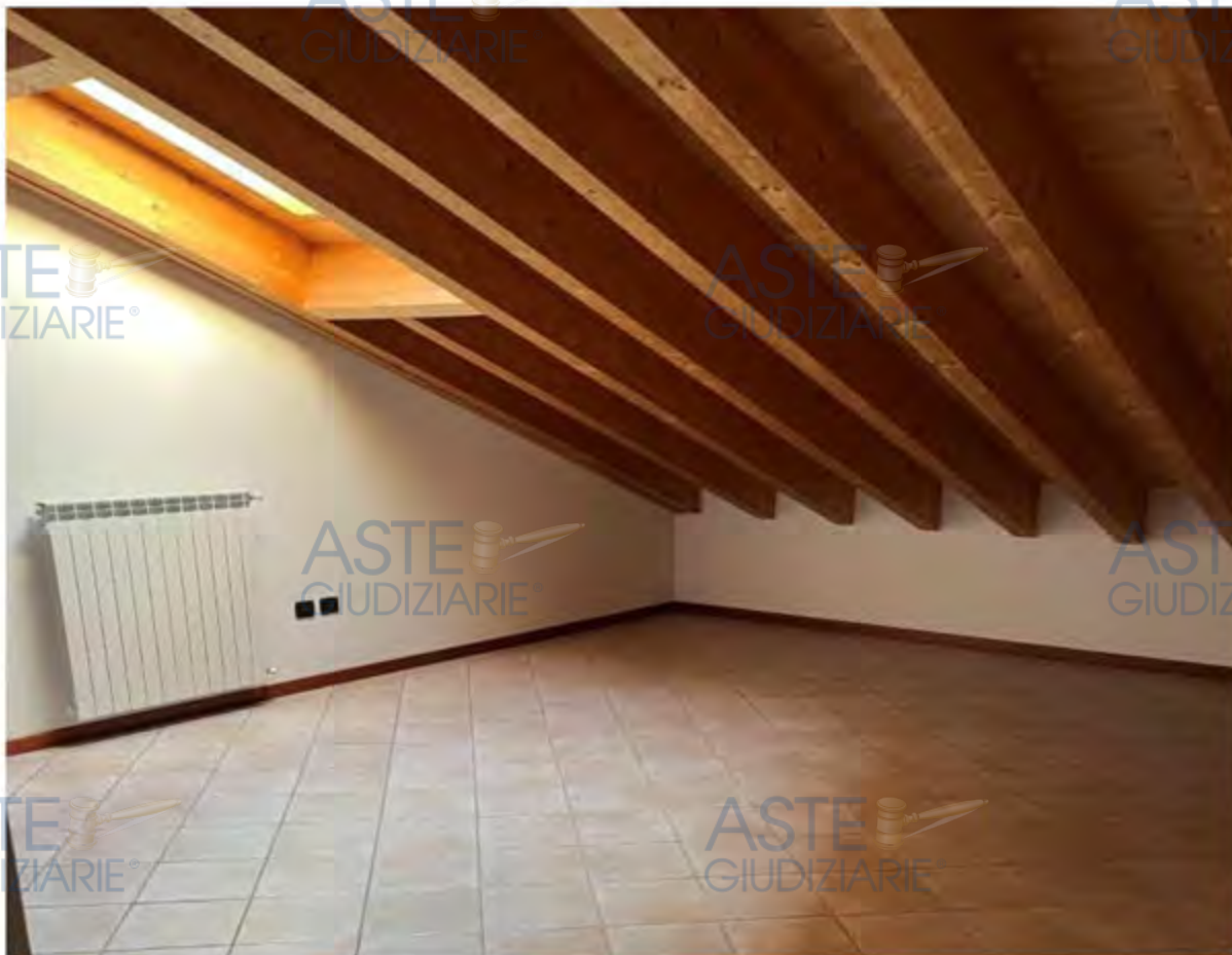
Soffitta al piano secondo
