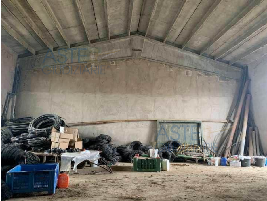
Mapp 434 – capannone – testata ovest - interno
