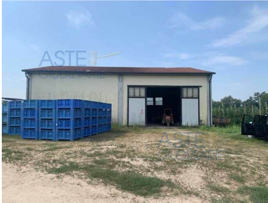
Mapp 434 – Confine nord: piazzale carico e prospetto nord capannone
