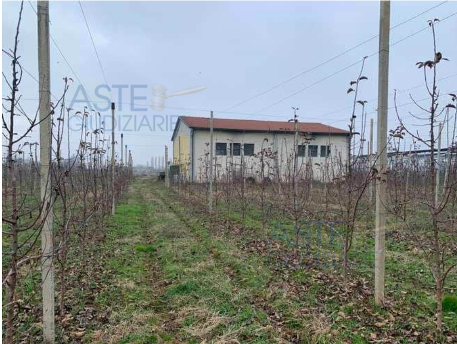
Mapp 434 – confine sud e prospetto sud capannone
