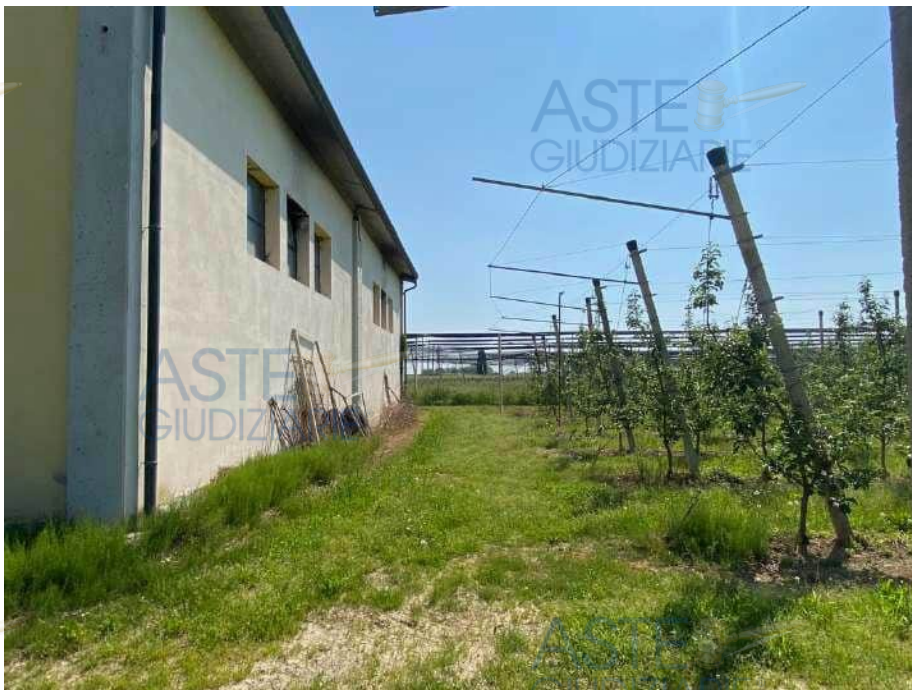
Mapp 434 – confine est e prospetto est capannone
