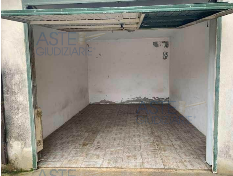
Mapp. 491 - Locale deposito 2
