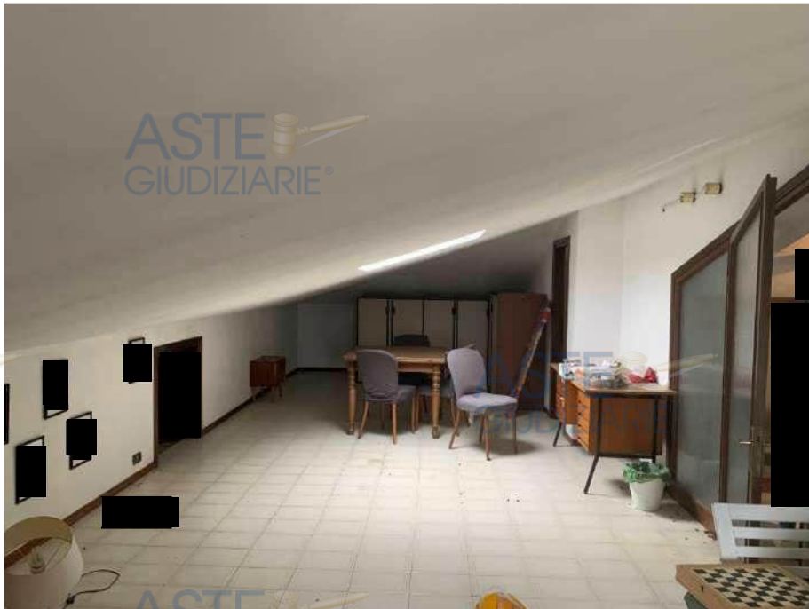
Mapp. 192 sub 1 - Sottotetto non abitabile da sanare: locale 1
