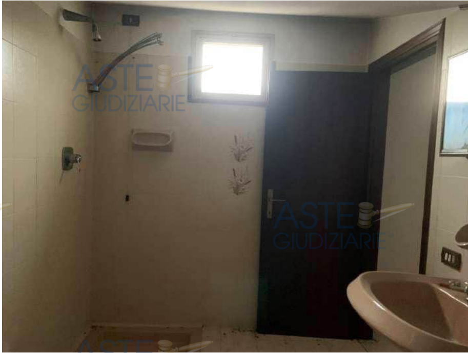
Mapp. 192 sub 1 - Sottotetto - Bagno da rimuovere -
