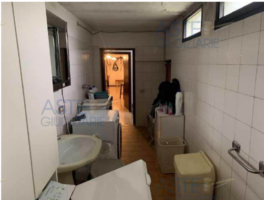
Mapp. 192 sub 2 - Intercapedine - Bagno da rimuovere -
