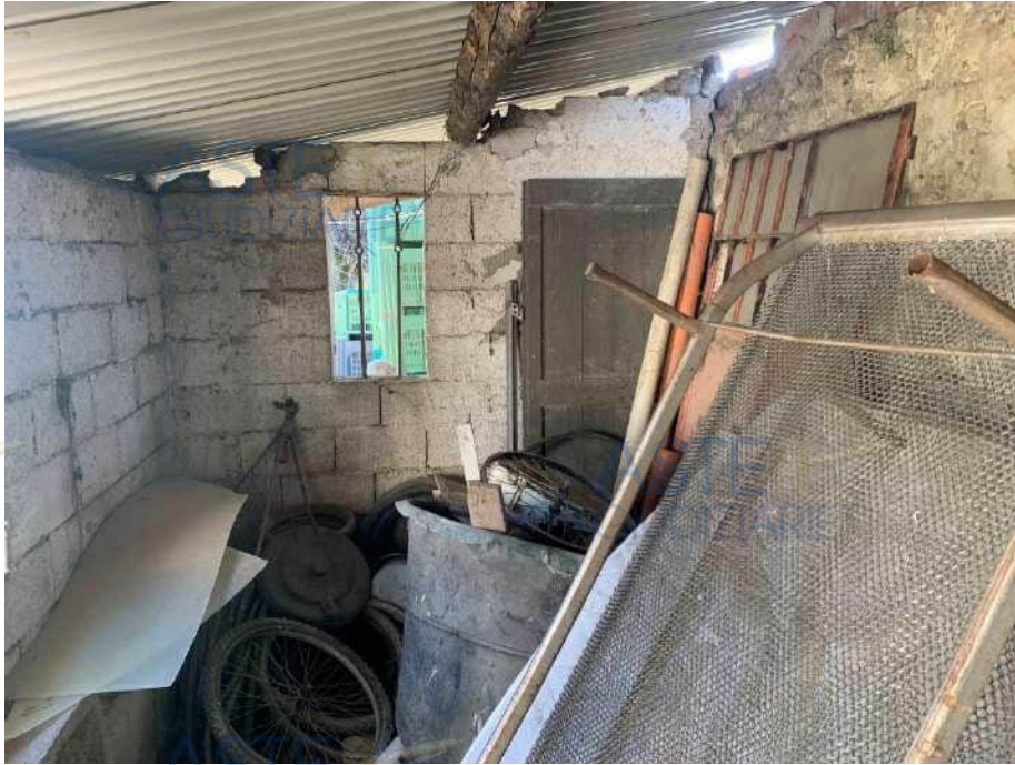
Mapp. 491 - Locale deposito 5
