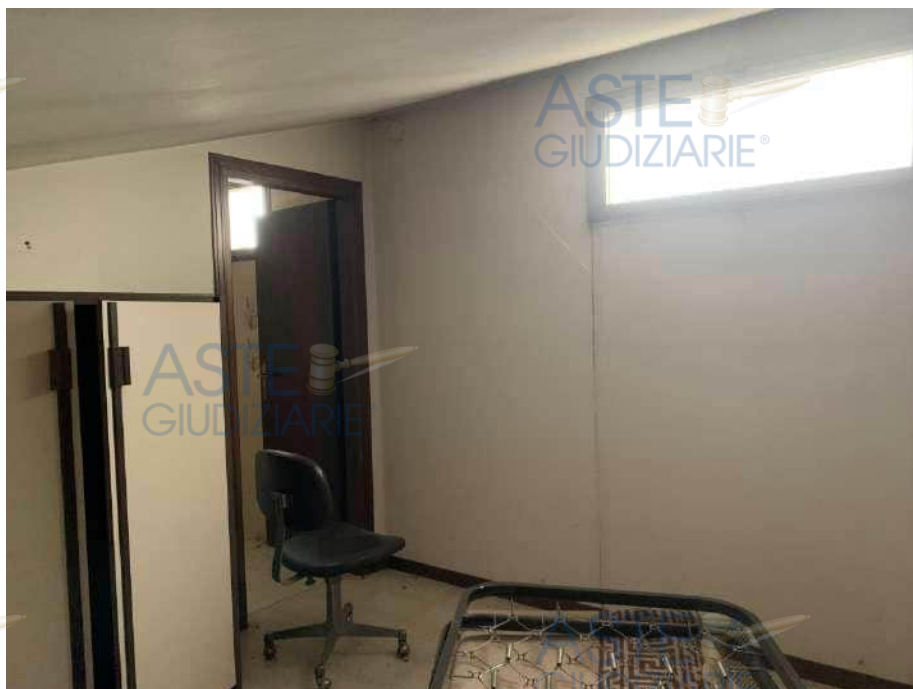
Mapp. 192 sub 1 - Sottotetto non abitabile da sanare: locale 2
