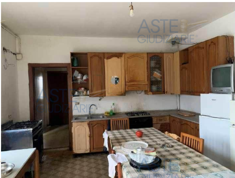
Mapp. 491 - Locale mensa da ripristinare come da progetto
