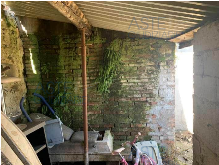
Mapp. 491 - Locale deposito 5
