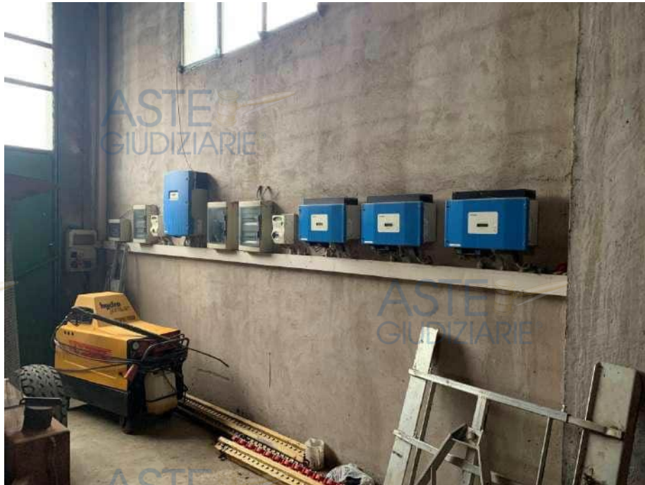
Mapp. 491 - Deposito Attrezzi 2 (fotovoltaico)
