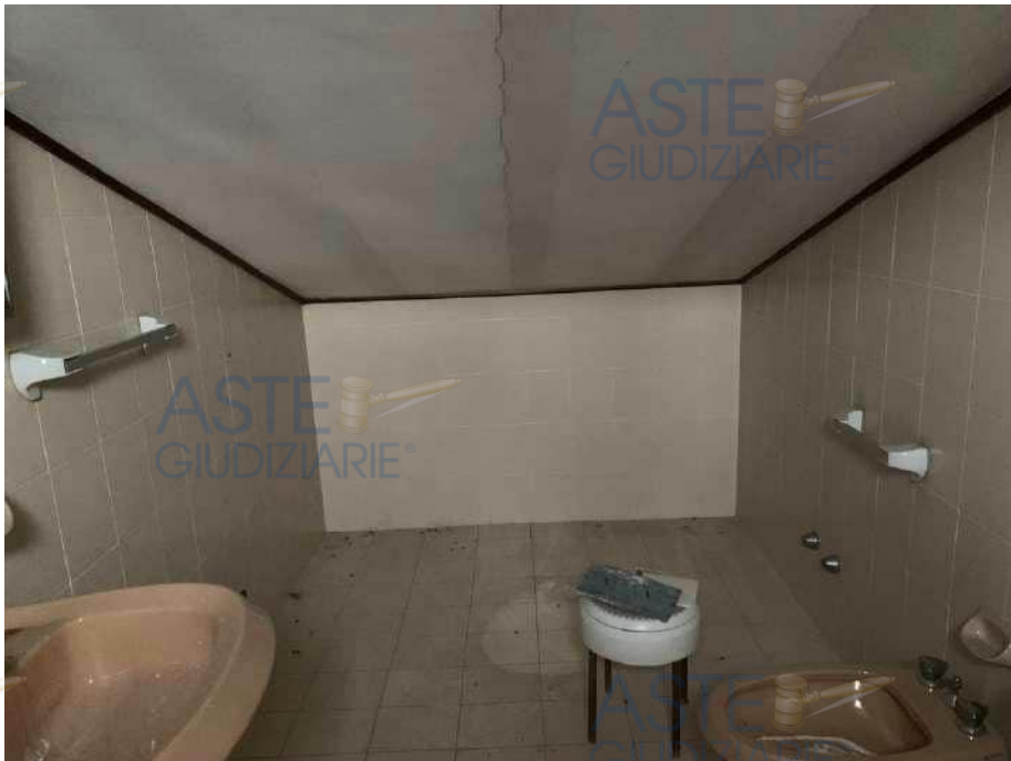
Mapp. 192 sub 1 - Sottotetto - Bagno da rimuovere -
