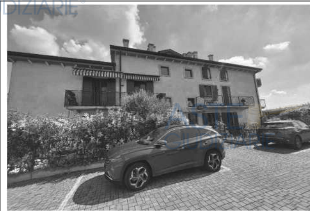
Figura 9: ripresa fotografica del fabbricato effettuata dalla corte comune
