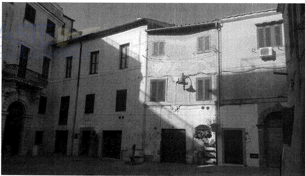
Vista dello stabile da Piazza Segneri
