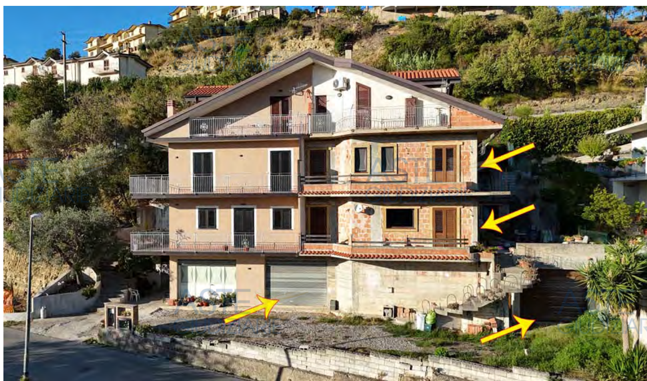
Figura 3 – Con le frecce sono indicate le porzioni di palazzina sottoposte ad esecuzione
