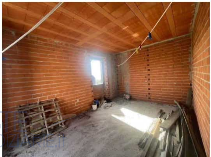
Fig. 15 Interno - Piano Primo.
