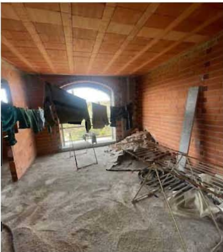
Fig. 14 Interno - Piano Primo.
