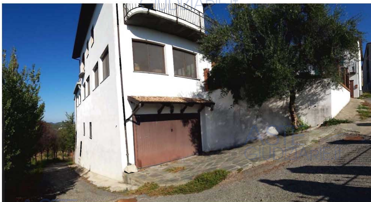
Fig. 2 Vista Prospetto EST del Piano terra.
