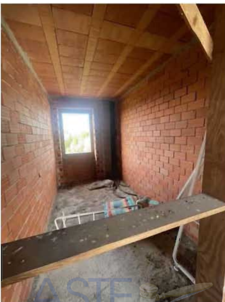
Fig. 16 Interno - Piano Primo.
