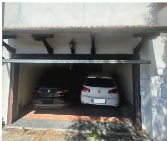
Fig. 11 Rimessa al Piano seminterrato.
