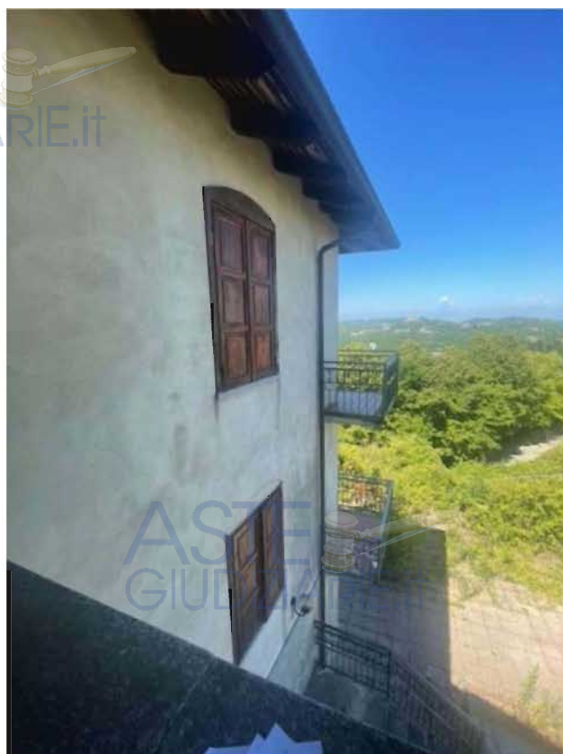
Fig. 9 Vista della facciata dal terrazzo coperto.
