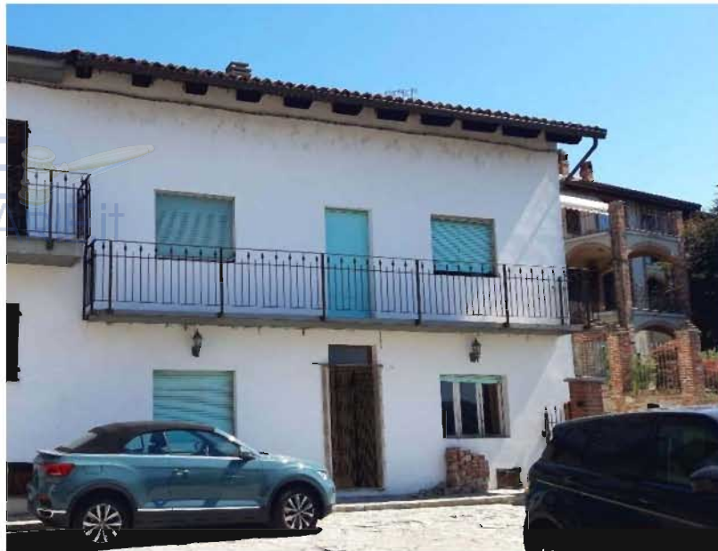
Fig. 1 Facciata dell'immobile corpo a Nord.
