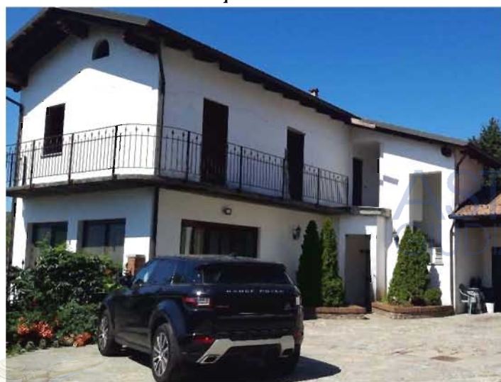
Fig. 8 Facciata dell'immobile corpo a Sud.
