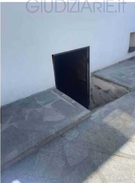
Fig. 6 Accesso a Cantina dal Cortile comune.
