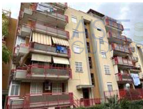
Facciata prospiciente l'atrio interno
