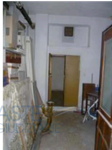
Vista interna Accesso Locale Interrato
