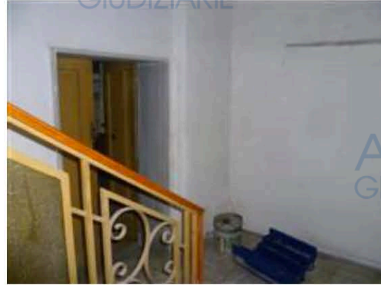
Vano scala Accesso Locale piano Interrato
