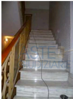
Vano scala Accesso Locale piano Interrato
