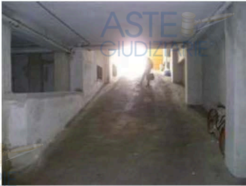
Vista interna rampa carrabile comune dipartente dal piano interrato
