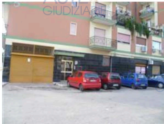
Accesso carrabile piano interrato
