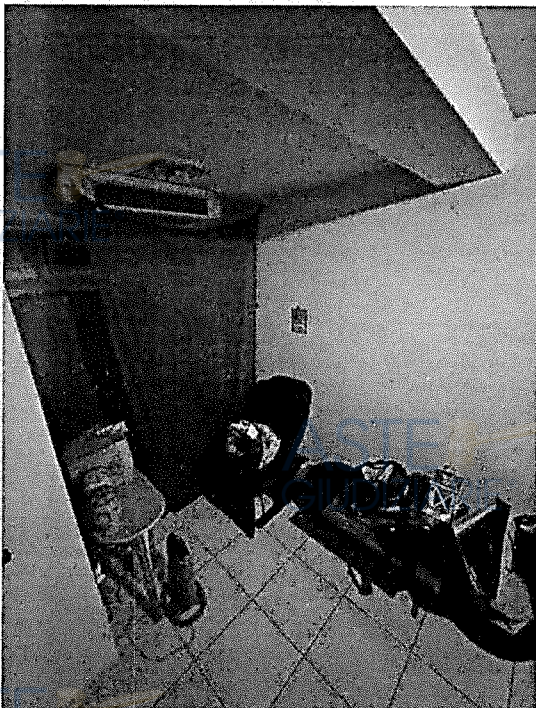
piano interrato vista locale deposito e scala di accesso
