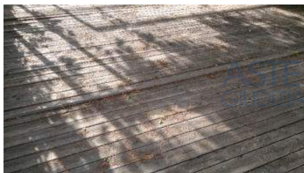
Terrazzo p. primo_pavimento_07
