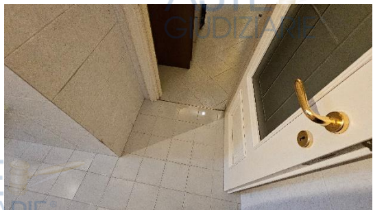
Particolare dei pavimenti
