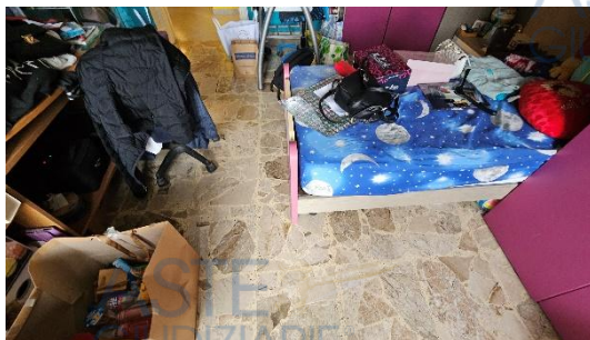
Particolare dei pavimenti
