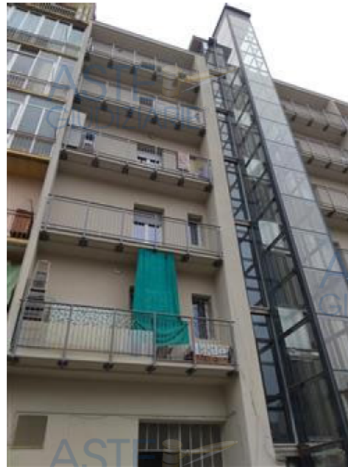
prospetto dell'edificio verso cortile interno
