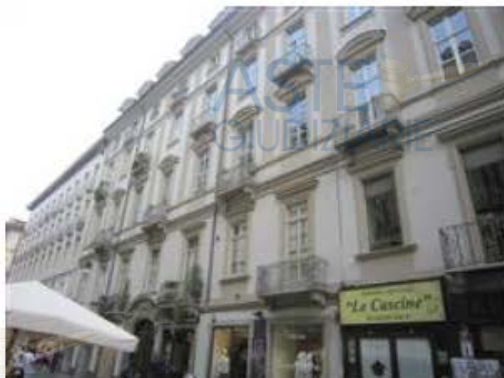
Facciata su Via Garibaldi
