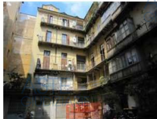
Facciata su cortile interno
