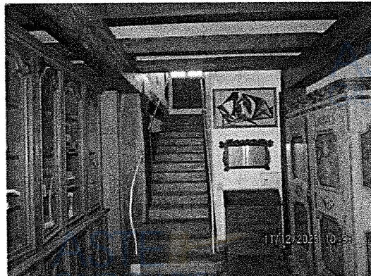
Scala di accesso 1° piano
