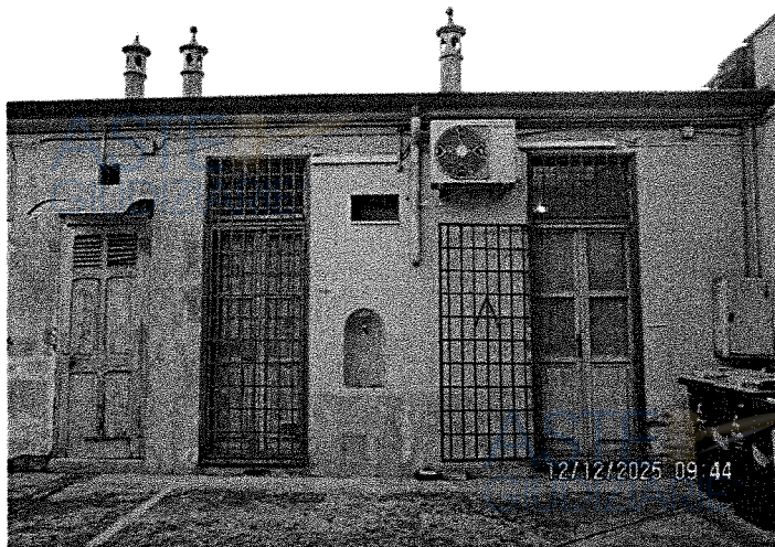
Facciata su cortile del basso fabbricato
