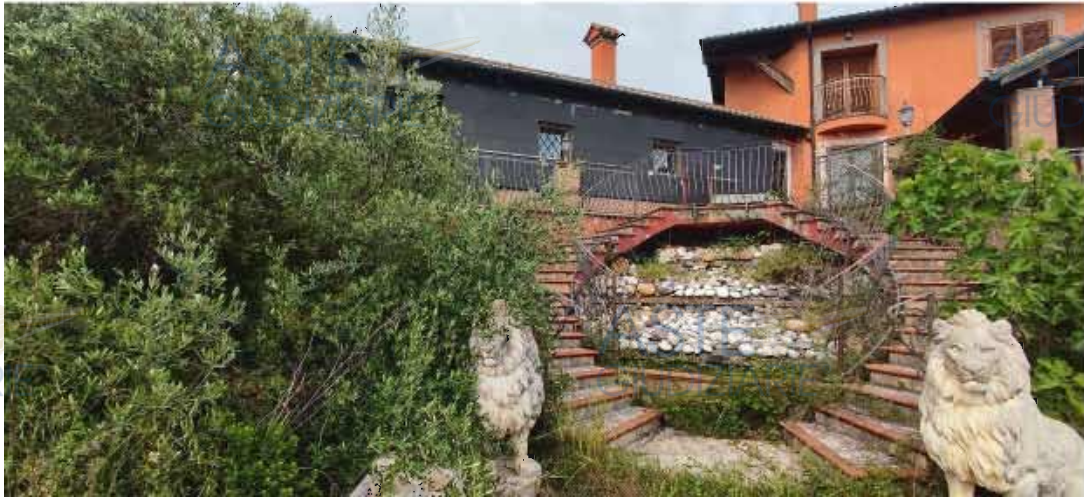
Lavori di isolamento energetico (terminati in data 26/01/2024)
