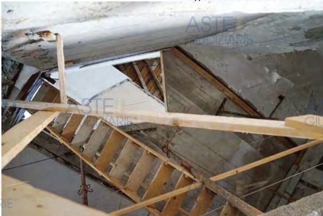
visuale dal vano scala
