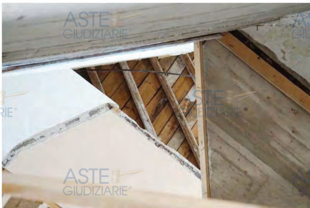
visuale dal vano scala
