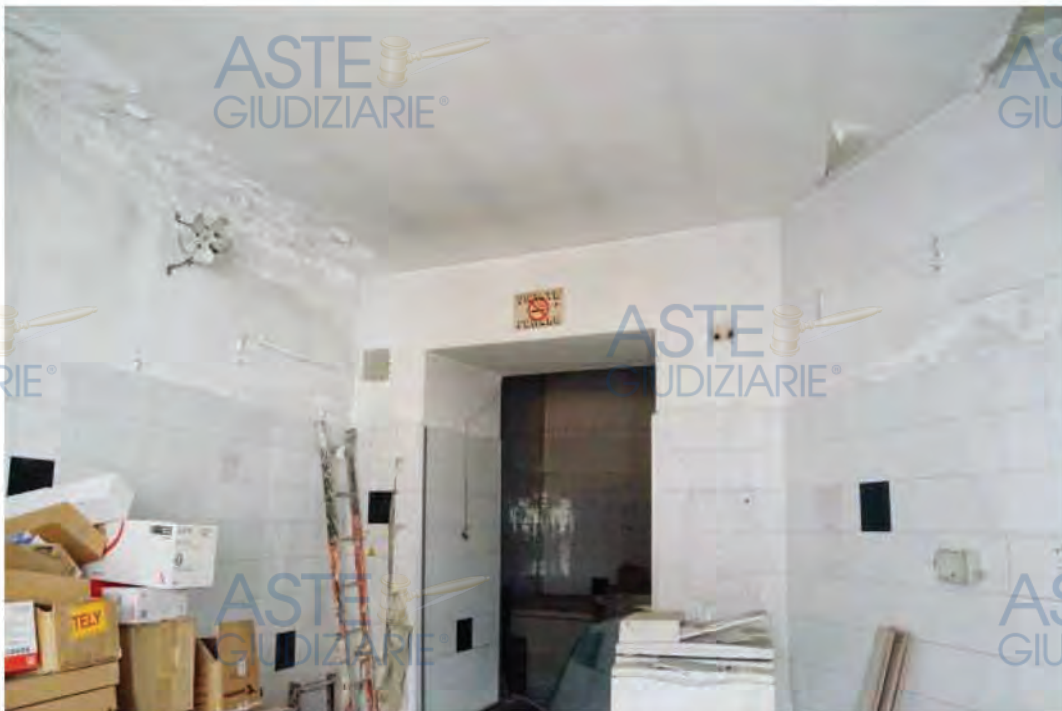
vano di accesso
