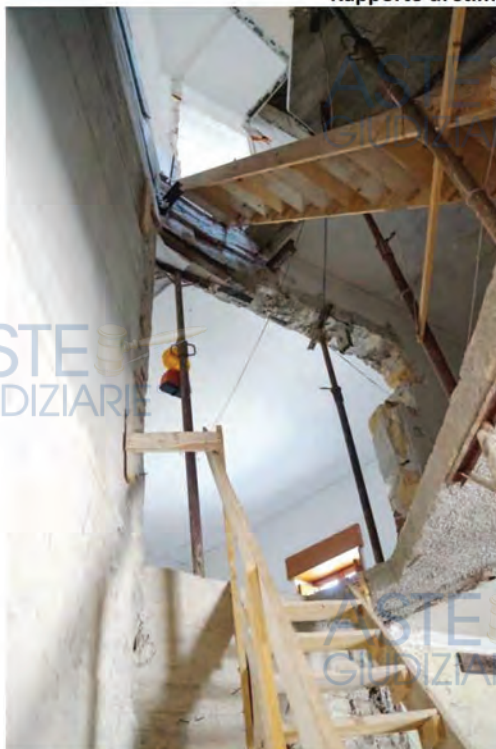
muro portante parzialmente demolito
