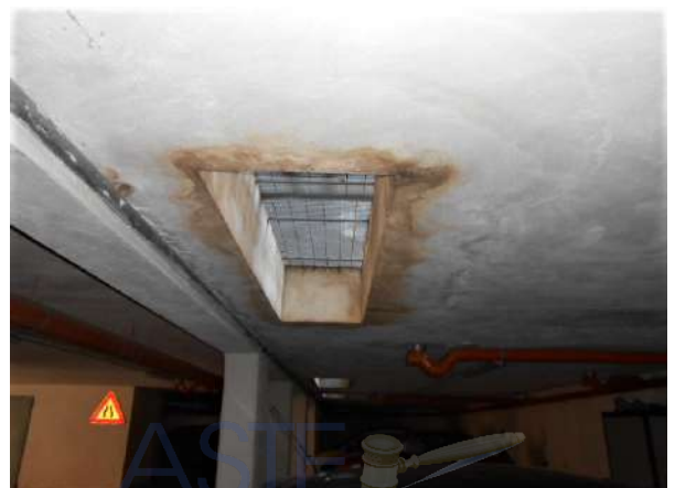
6. NEL PERIMETRO DEL LUCERNARIO NEL SOFFITTO DEL POSTO AUTO SI NOTANO MACCHIE DI UMIDITÀ PREGRESSA DA INFILTRAZIONI D'ACQUA DAL PIANO TERRA
