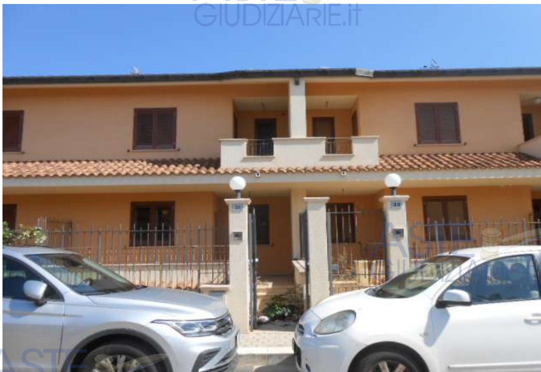
2. PROSPETTO SU VIA SANTA MARINA QUARTO, 21
