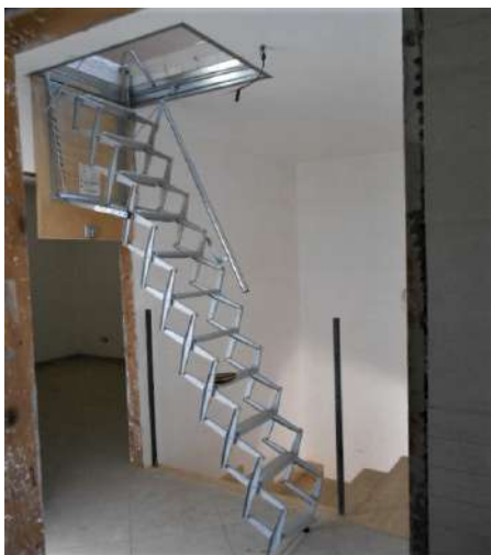
14. PIANO 1. LA SCALETTA RETRATTILE PER L'ACCESSO AL SOTTOTETTO
