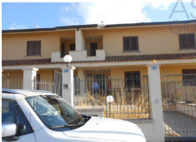
1. PROSPETTO SU VIA SANTA MARINA QUARTO CIV. 45-47
