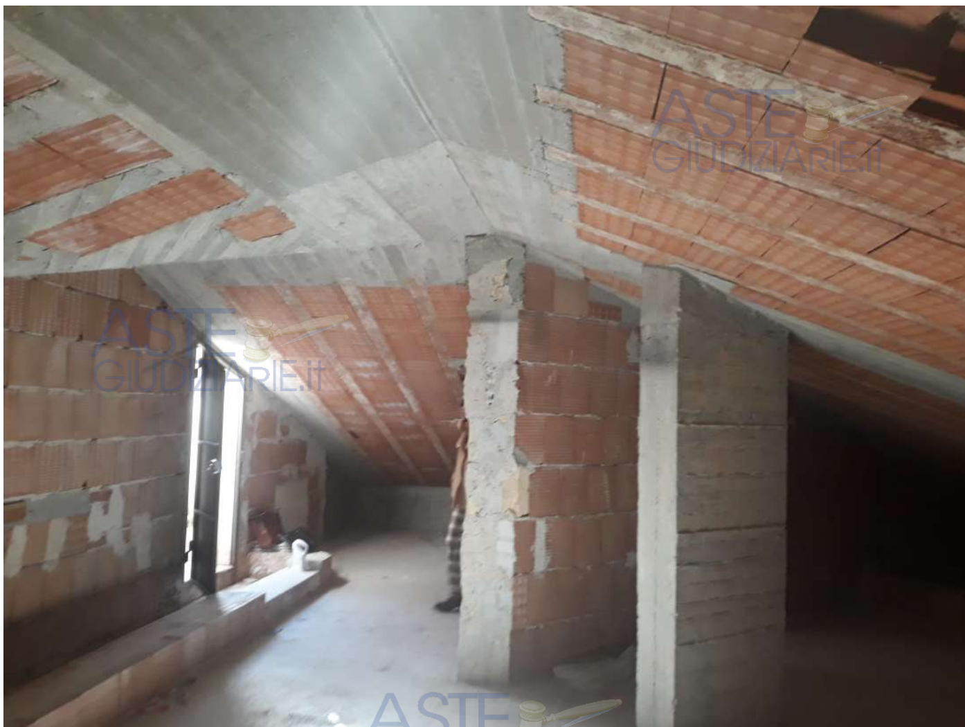
2. INTERNO DEL SOTTOTETTO
