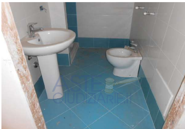
20. PIANO SOTTOSTRADA (S1). IL WC DOCCIA
