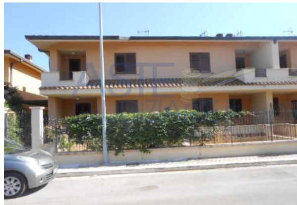
2. PROSPETTO SU VIA SANTA MARINA QUARTO, 29 - BAGHERIA
