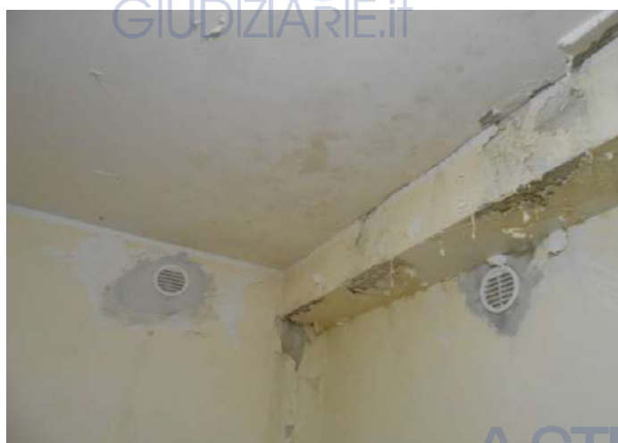
13. VASTE MACCHIE DI UMIDITÀ AL PIANO S1 DERIVANTI DA INFILTRAZIONI DALLE CORTI DEL PIANO TERRA
