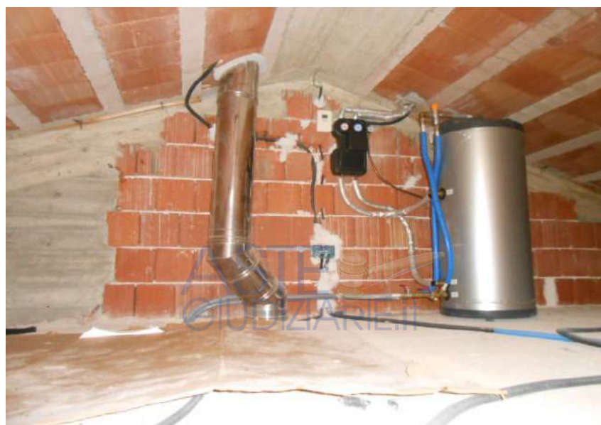
15. INTERNO DEL SOTTOTETTO
