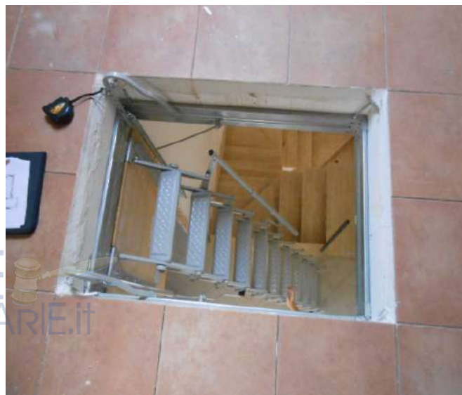
15. SOTTOTETTO. IL PAVIMENTO E LA BOTOLA CON A SCALETTA RETRATTILE
