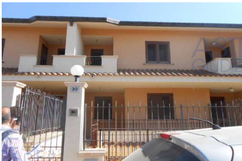
1. PROSPETTO SU VIA SANTA MARINA QUARTO, CIV 33
