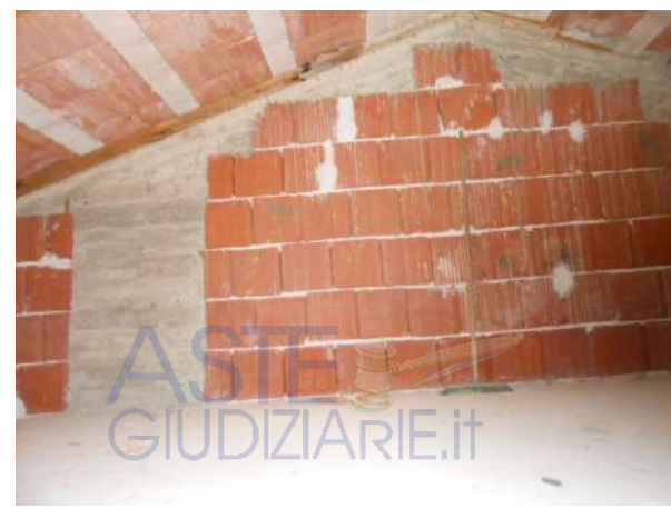
18. INTRADOSSO DI COLMO DEL SOTTOTETTO
