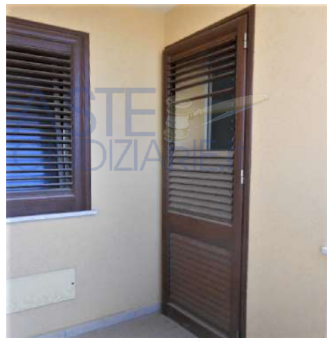
13. PIANO 1. L'INFISSO DELLA LOGGETTA È MANCANTE DI ALCUNE STECCHE INCLINATE (C.D. "GELOSIE") E OCCORRE RIPRISTINARLE.
