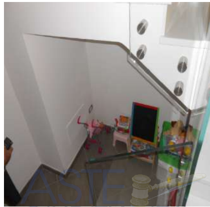
20. PIANO SOTTOSTRADA (S1). PARTICOLARI DELLA SCALA
