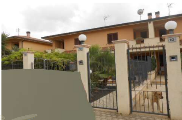
11. PROSPETTO SU VIA SANTA MARINA QUARTO
