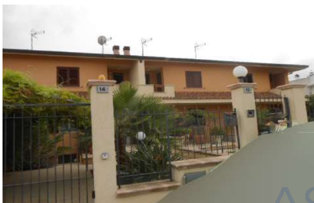
10. PROSPETTO SU VIA SANTA MARINA QUARTO
