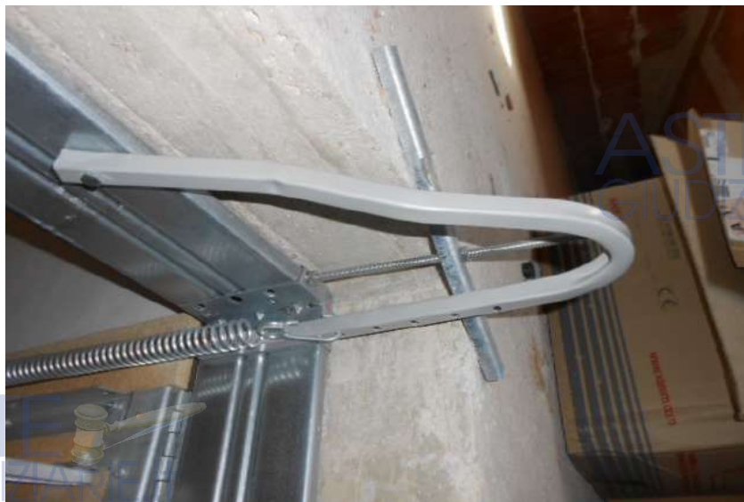
14. PARTICOLARE DEL CORRIMANO DI ARRIVO NEL SOTTOTETTO
