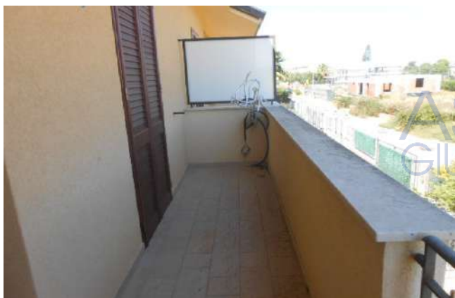
16. PIANO 1. BALCONE NORD LATO SANTA MARINA TERZO
