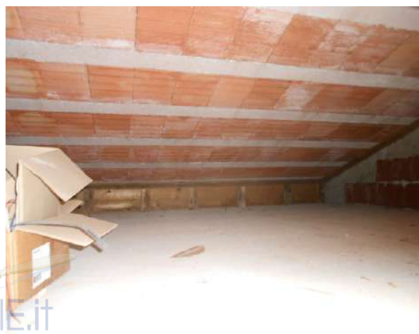
16. INTERNO SOTTOTETTO VISTA DELL' INTRADOSSO DI GRONDA
