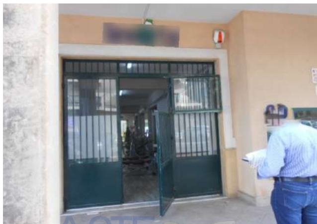
1. INGRESSO DAL PORTICATO SU VIA ROCCAFORTE
