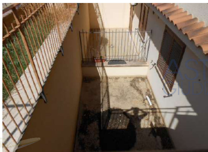
5. LA CORTE SUD DEL PIANO SOTTOSTRADA S1
