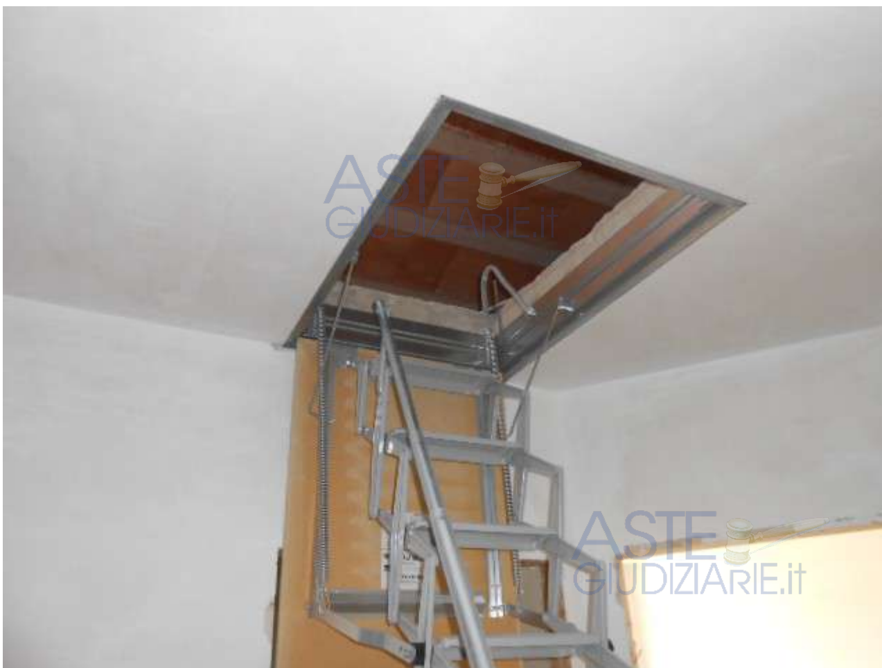
13. LA BOTOLA SOFFITTO PER L'ACCESSO AL SOTTOTETTO.
