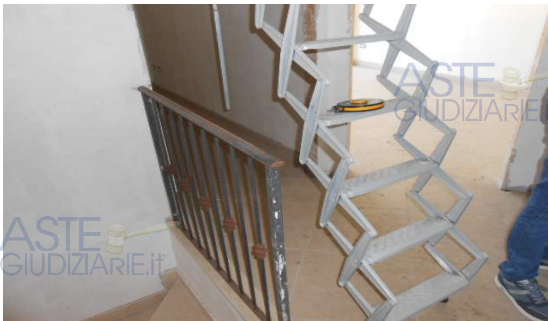
12. PIANO 1 BALLATOIO DI ARRIVO AL PIANO. PARTICOLARE DELLA SCALETTA RETRATTILE APERTA, PER ACCESSO AL SOTTOTETTO.
