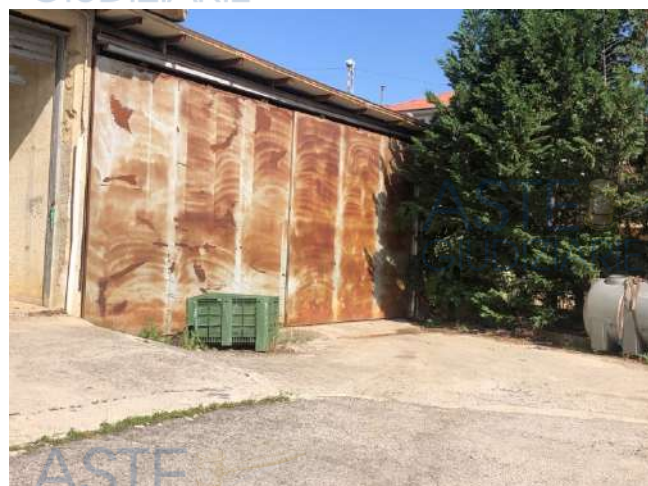
9. Particolare pannelli in ferro chiusura corte a sx
