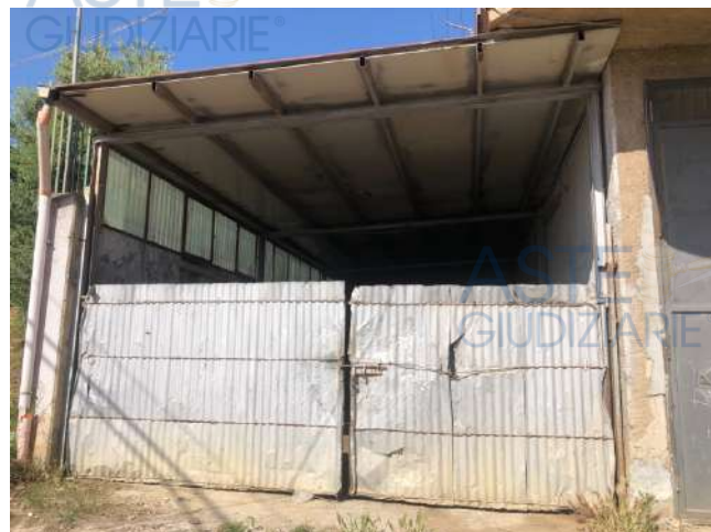
7. Particolare lamiera chiusura corte a sx
