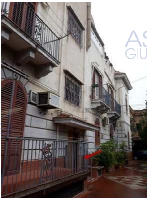
Foto 7– Corte comune Retroprospetto Indicazione androne
