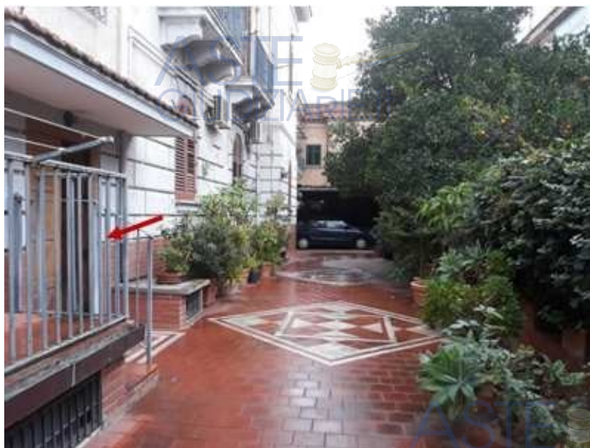
Foto 8– Corte comune Retroprospetto Indicazione androne
