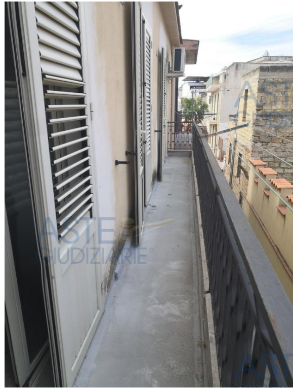
Foto n. 9 • piano secondo • balcone
