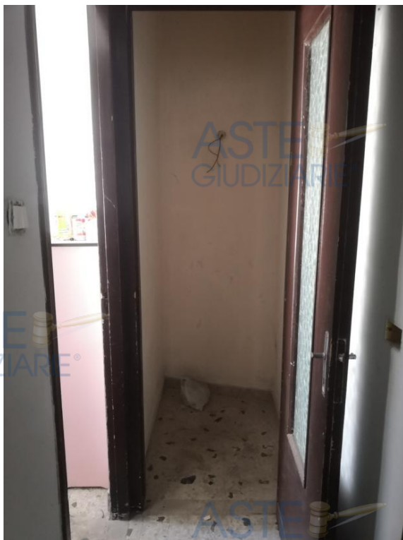
Foto n. 6 • piano secondo - ripostiglio
