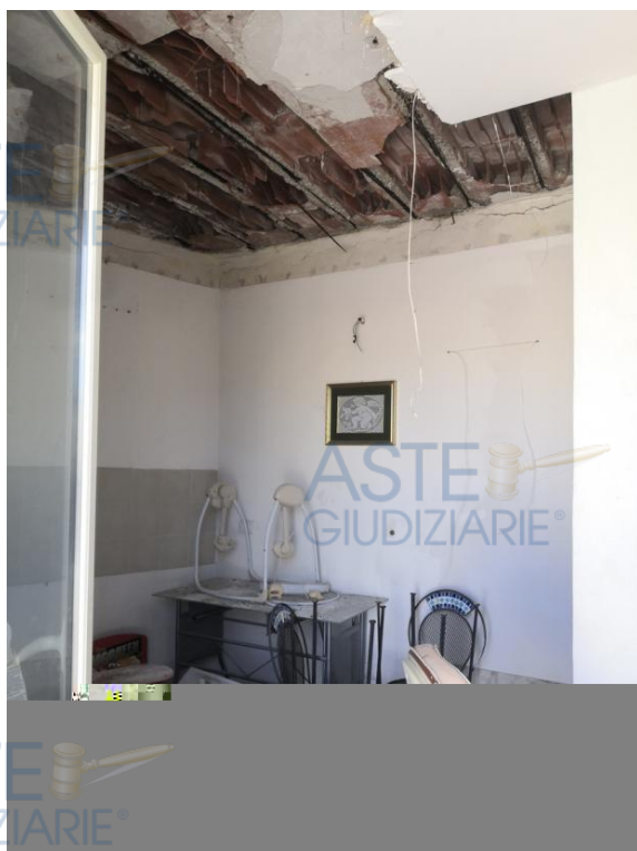
Foto n. 12 - piano terzo - sfondellamento solaio
