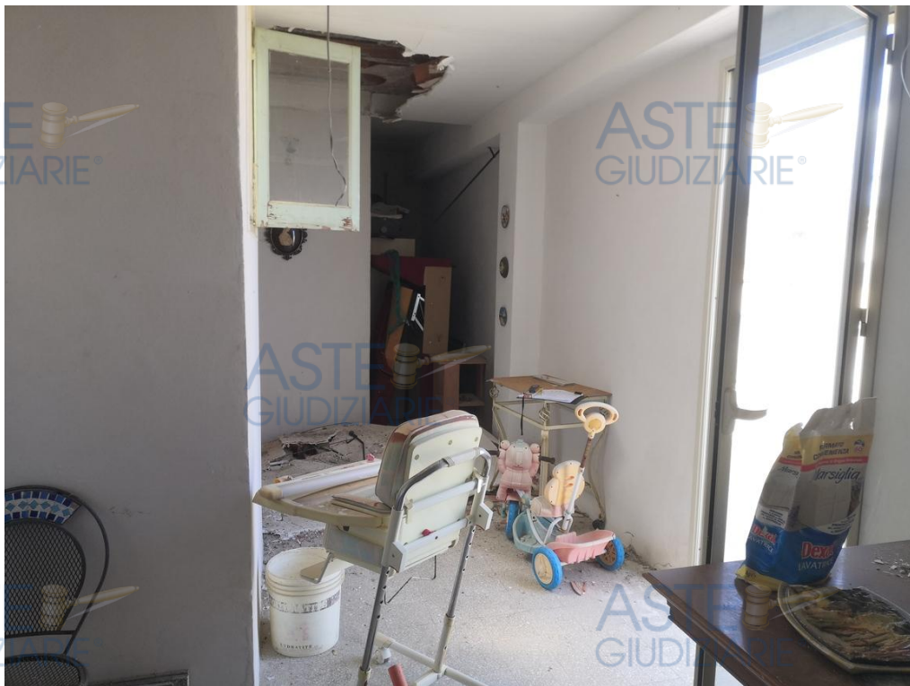
Foto n. 10 - piano terzo - vano
