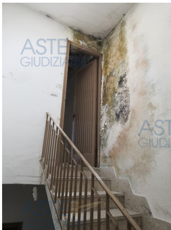
Foto n. 13 - piano terzo - scala - infiltrazioni
