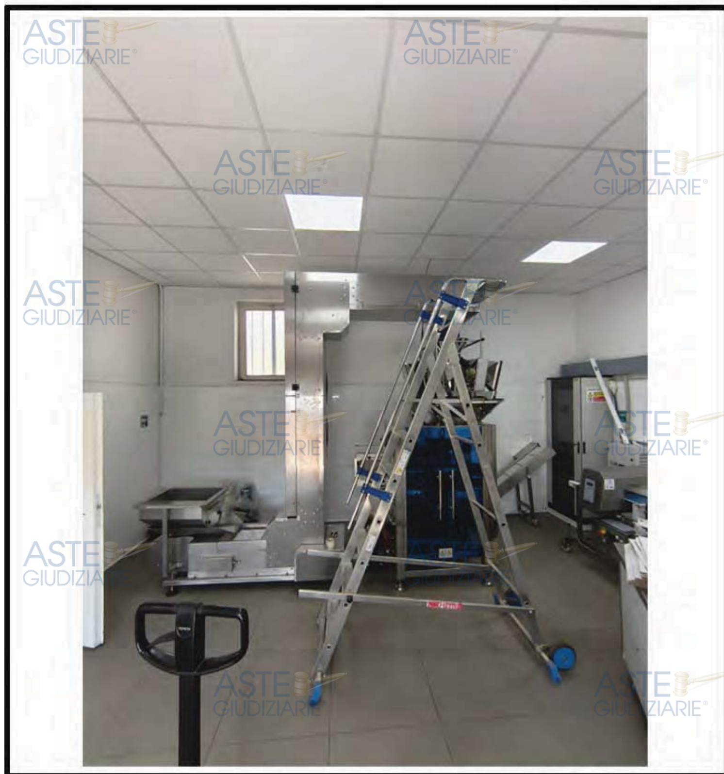
MACCHINARI DELLA LINEA 3 DELLO STABILIMENTO DI TORRE DEL GRECO NASTRO TRASPORTATORE
