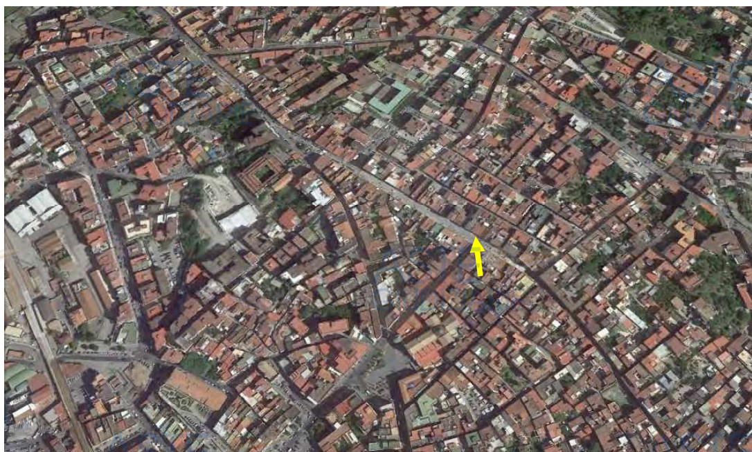
Vista Aerea di Torre del Greco (Na) con l'individuazione dell'immobile sito alla Via Roma
