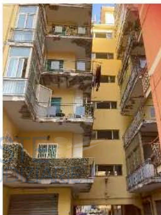
Figura 36- vista parziale fabbricato
