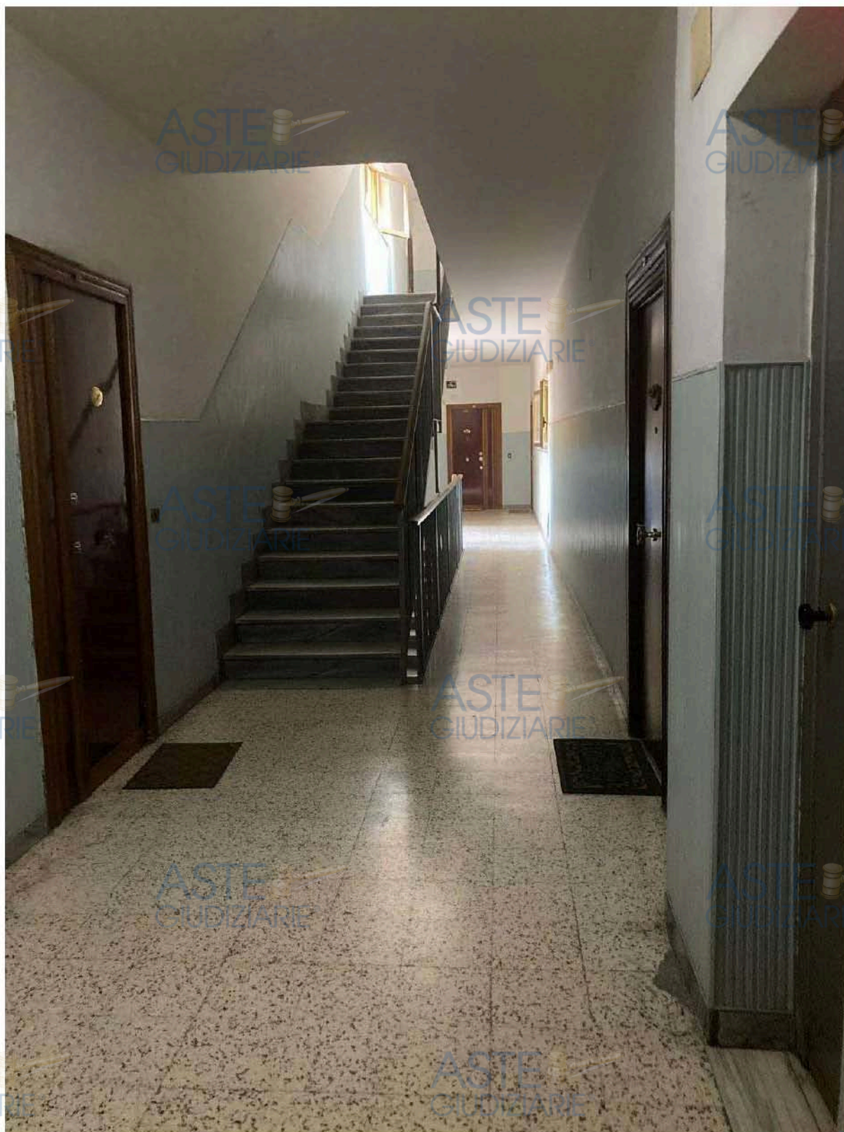
Figura 52- vista rampa del vano scala
