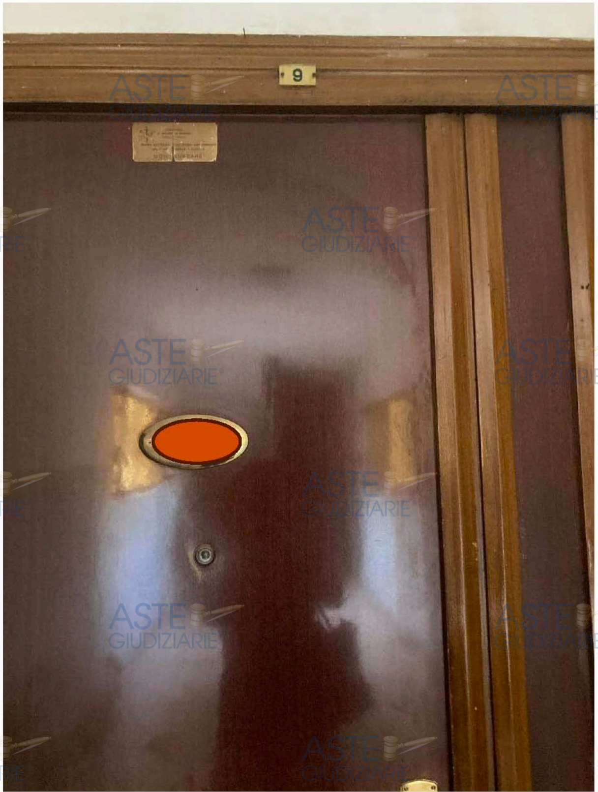
Figura 53- porta di accesso all'unità immobiliare n. interno 9
