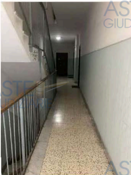
Figura 39- vista ballatoio accesso all'appartamento
