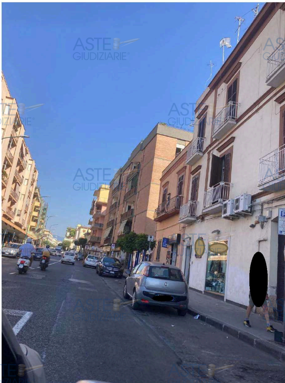
Figura 44- vista sulla via Nazionale
