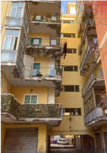
Figura 4- vista parziale fel fabbricato- corpo scala
