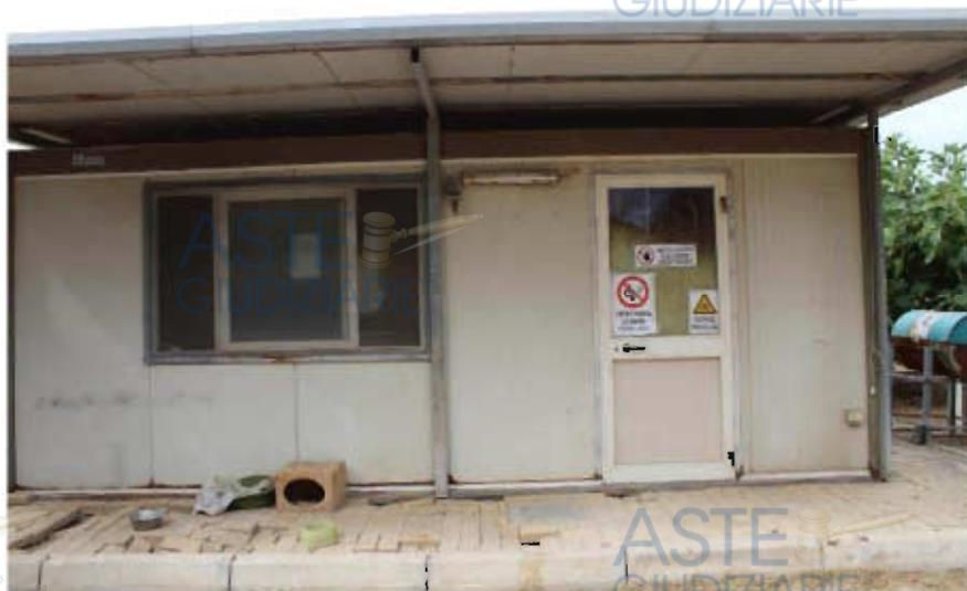
Fig. 17) Prospetto del prefabbricato "D" - in primo piano si notano i cedimenti differenziali del terreno su cui è posato il marciapiede
