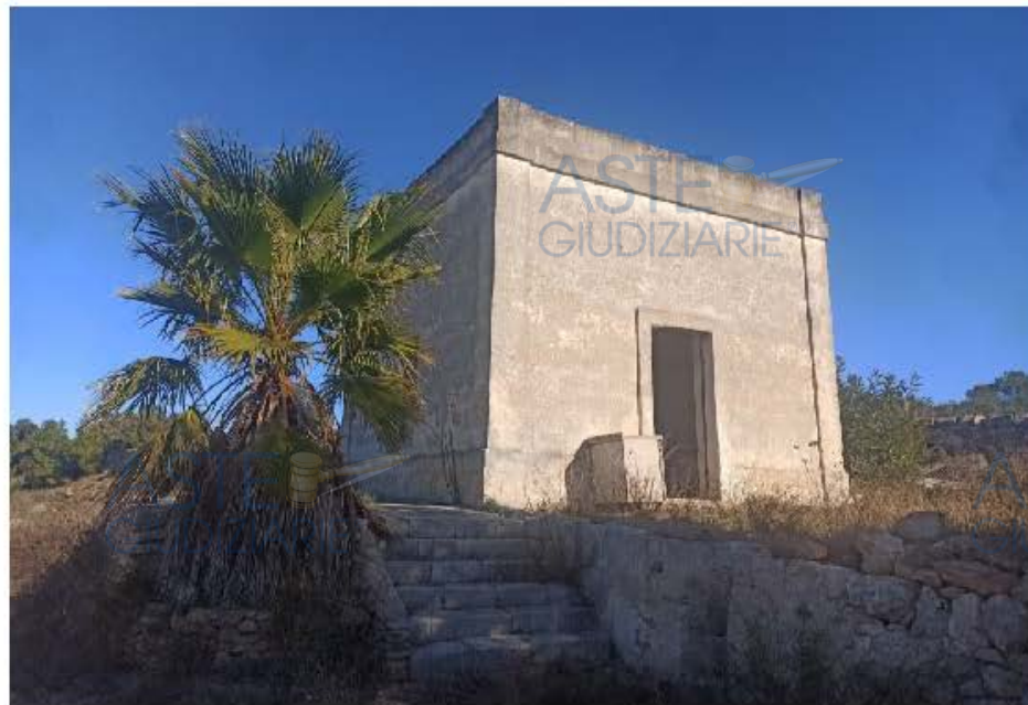
Il fabbricato secondario
