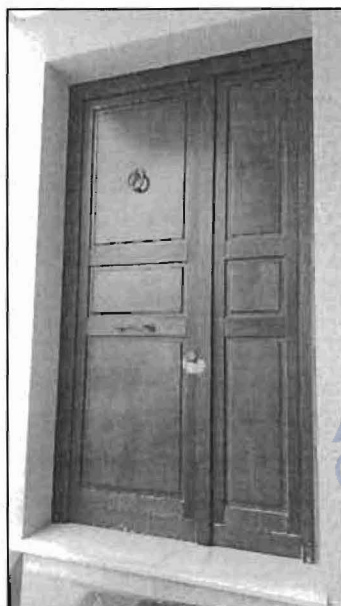
Foto 7 - Vista portoncino in legno d'ingresso
