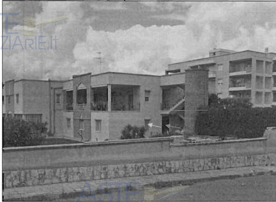
Foto 4 - Vista prospettica del fabbricato - da Via Iacovazzo - cui fa parte l'immobile oggetto di pignoramento (delimitazione linea celeste) con vista delle finestre delle 3 camere da letto e del bagno 1 (quest'ultimo indicato con la freccia gialla), nonché portoncino d'ingresso alla villetta (freccia verde).
