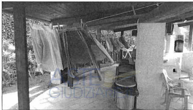
Foto 21 – Vista posteriore tettoia "a ventaglio".
