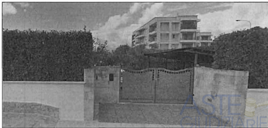
Foto 5 - Dettaglio accesso carraio
