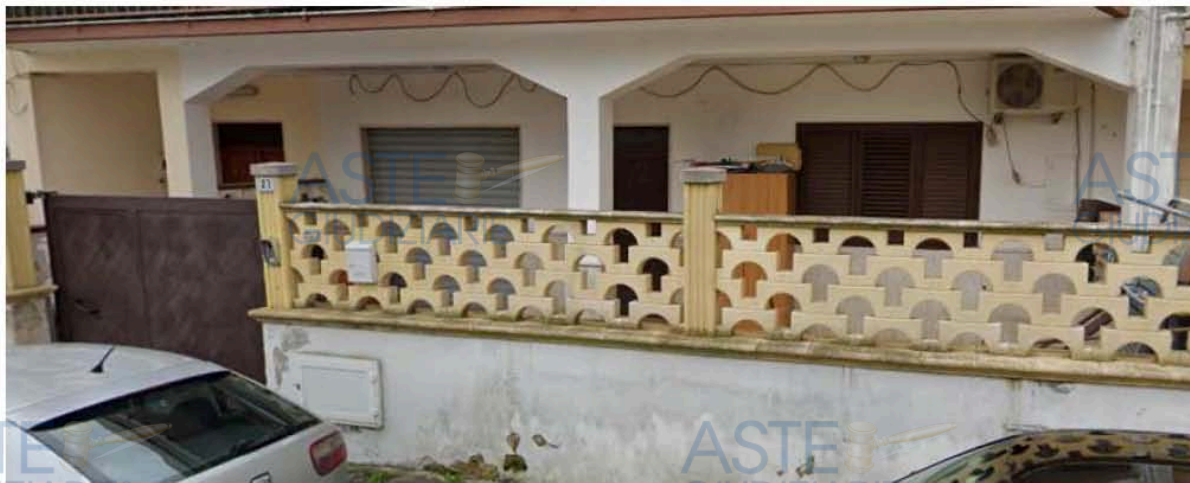
Figura 4 – Stato dei luoghi prima della riconversione del locale garage (fonte Google Maps)
