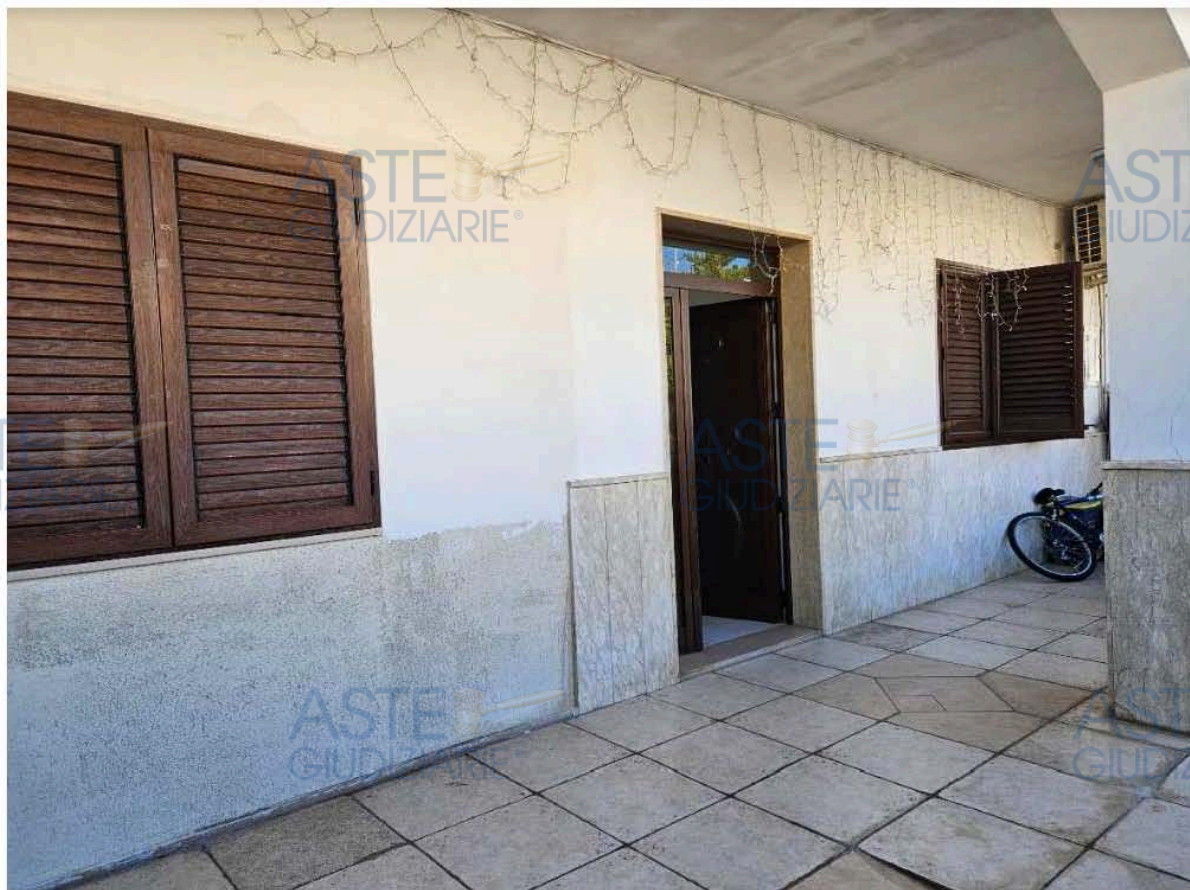
Figura 5 – Stato dei luoghi post riconversione del locale garage
