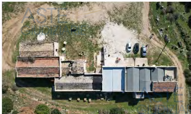
Foto 3 – Vista dall'alto del fabbricato
