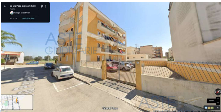
Fig. 5) Vista dell'accesso all'area condominiale ed al piano seminterrato da Via Papa Giovanni XXIII n. 45 estratta da Google maps
