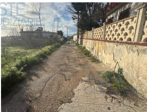
Strada prospiciente la recinzione dell'u.i.u.
