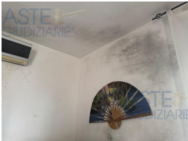
Macchie di condensa – ingr.cucina
