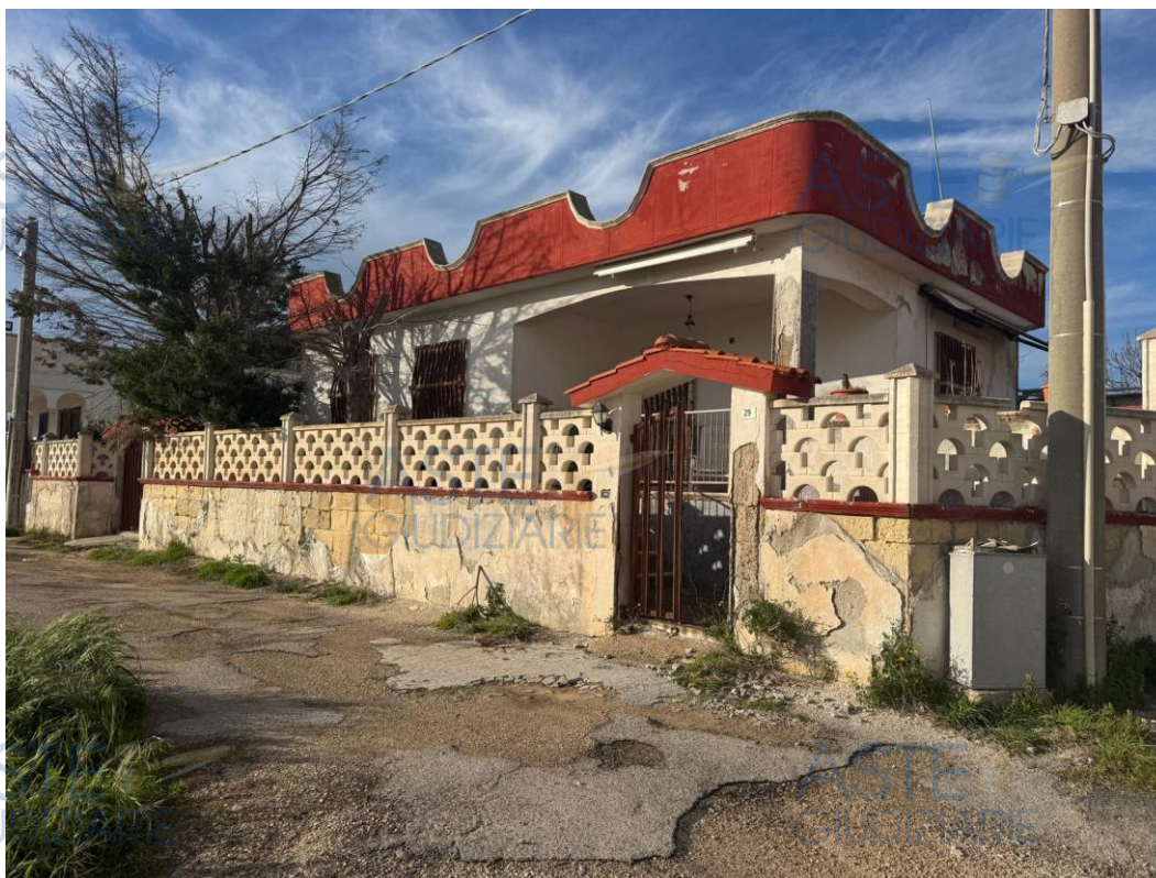
Prospetto principale, Contrada Monache
