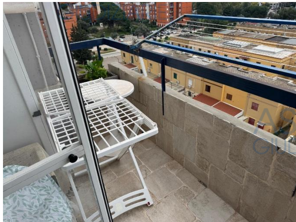
Balcone Viale della Tecnica
