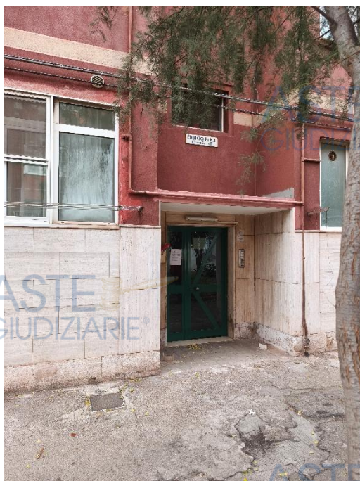
Fig. 4) Portone di accesso alla scala B dell'edificio F1
