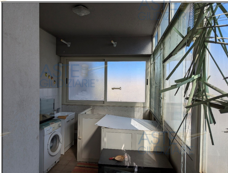
Foto n° 12 – Ballatoio 1 chiuso con struttura metallica
