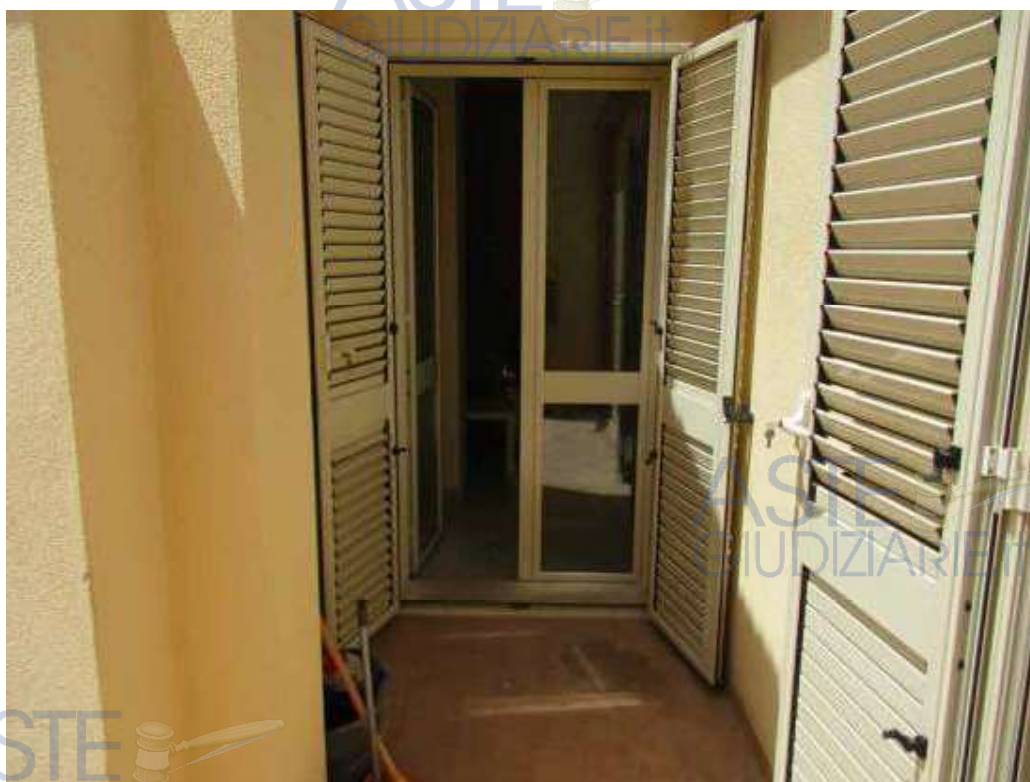
Foto 14 – LOTTO A - Terrazzino
