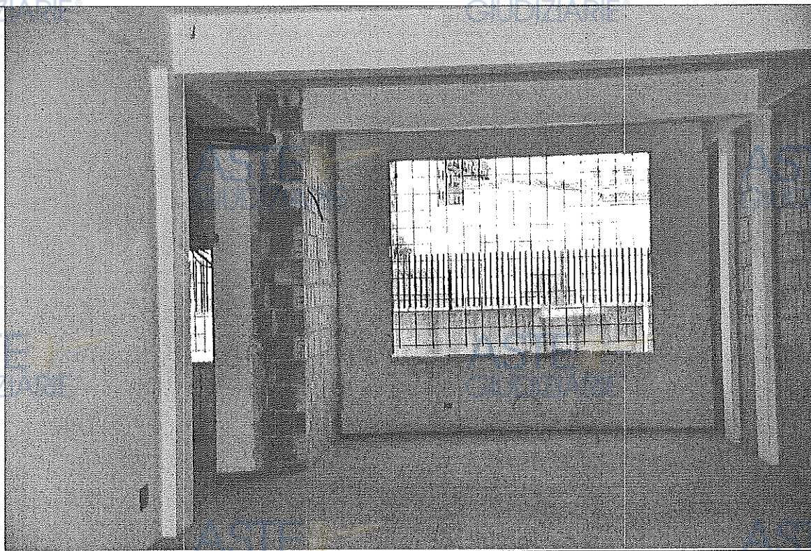
Foto n. 25 – Vista dell'immobile al piano terra sub 2
