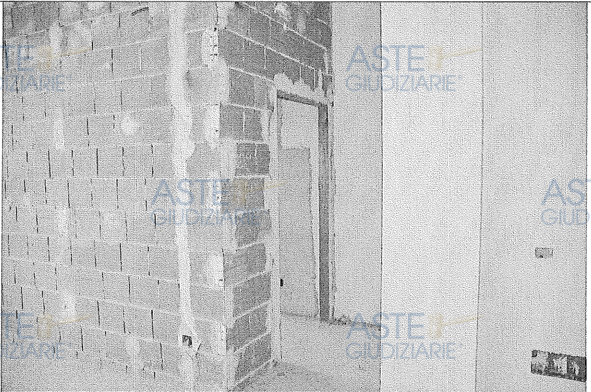
Foto n. 28 - Vista dell'immobile al piano terra sub 3
