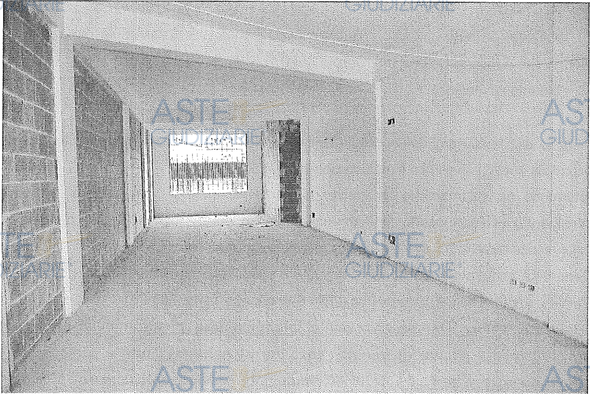
Foto n. 27 - Vista dell'immobile al piano terra sub 3
