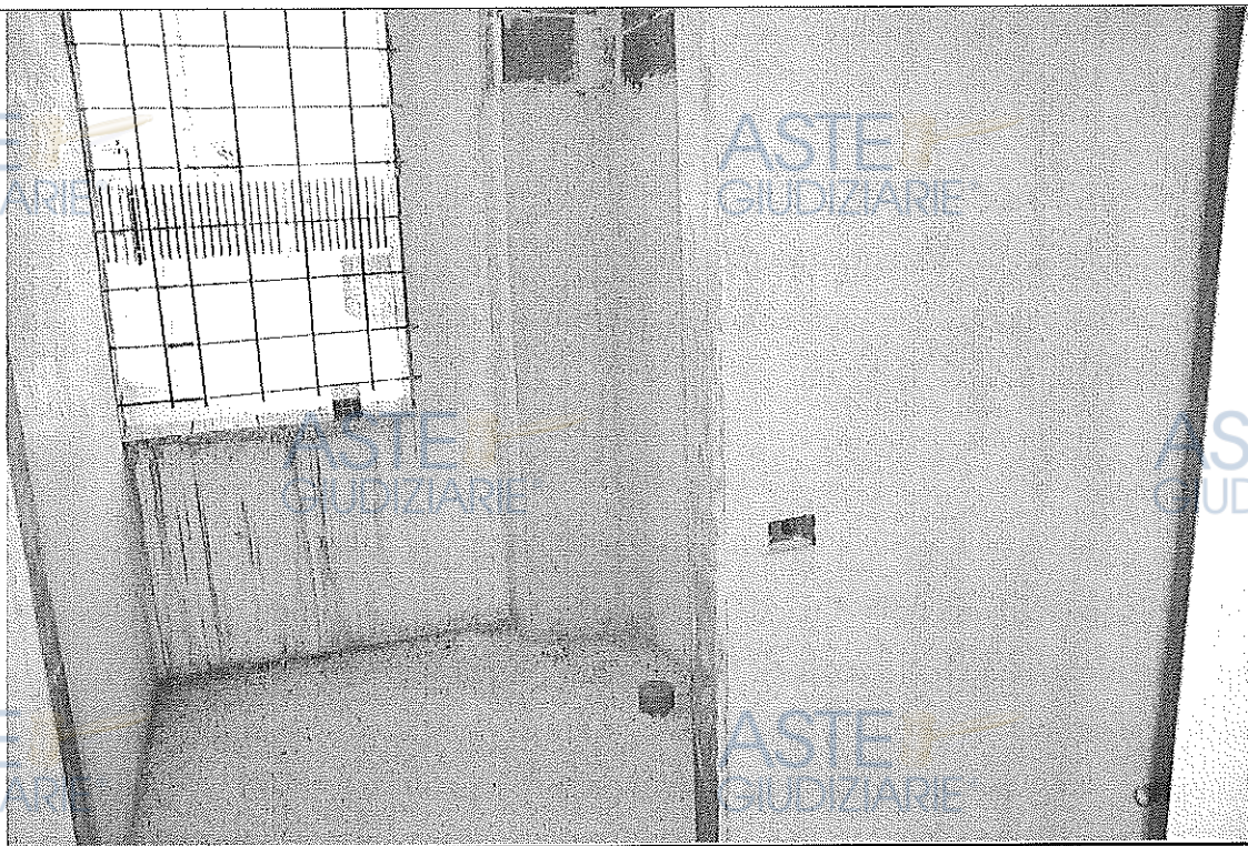
Foto n. 26 - Vista dell'immobile al piano terra sub 2
