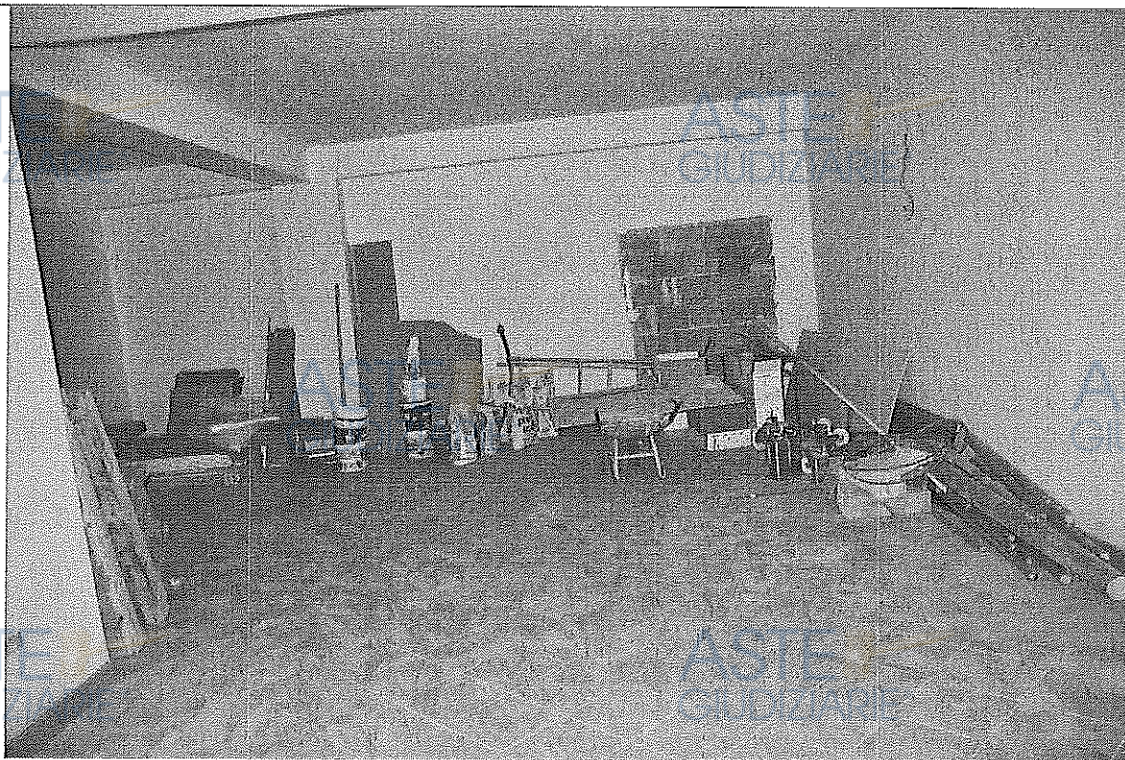
Foto n. 18 – Vista interna del garage sub 23
