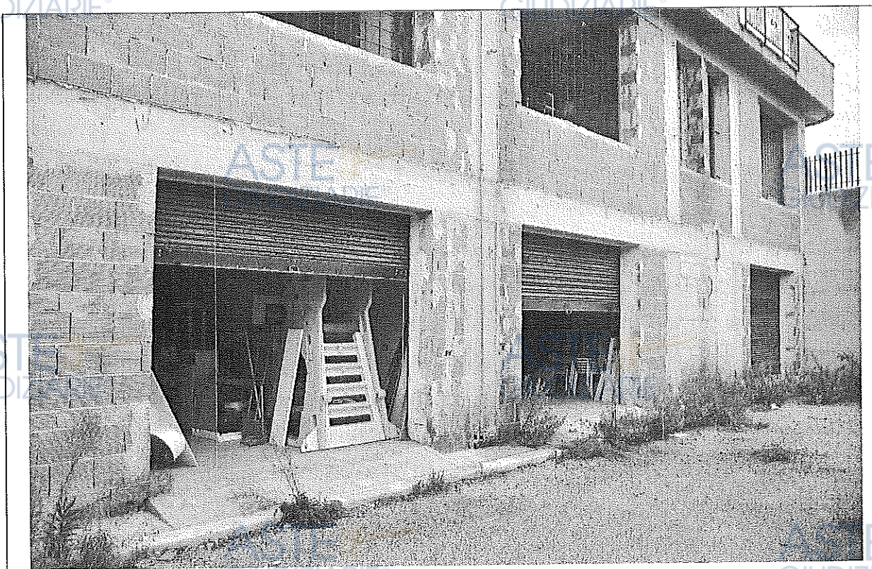
Foto n. 11 – Rampa secondaria di accesso al garage
