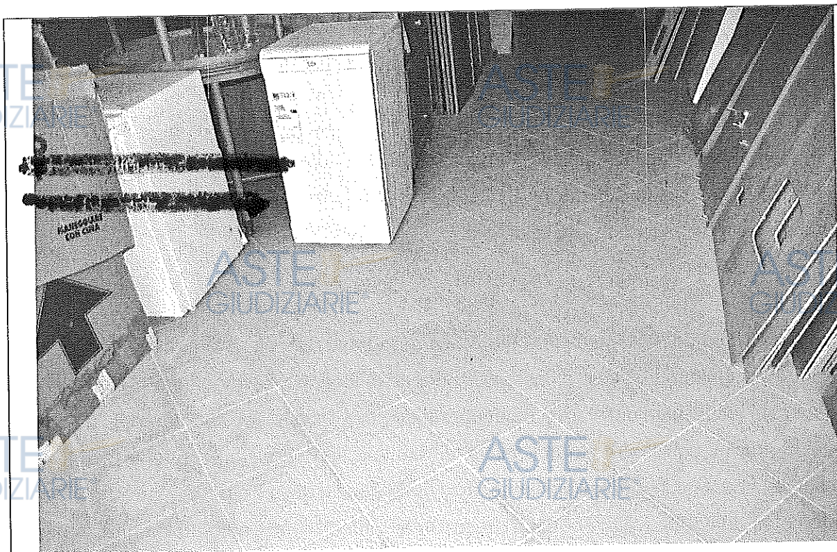
Foto n. 8 – Garage sub 17, particolare della pavimentazione
