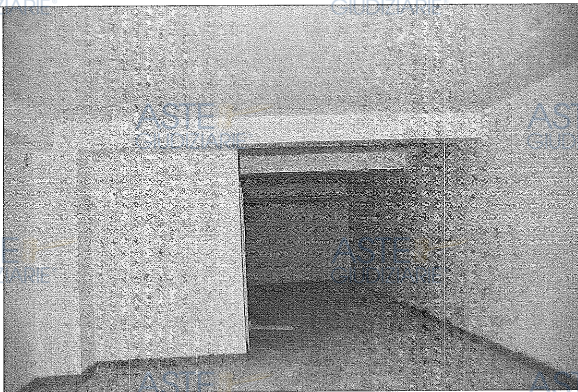
Foto n. 19 – Vista interna del garage sub 25
