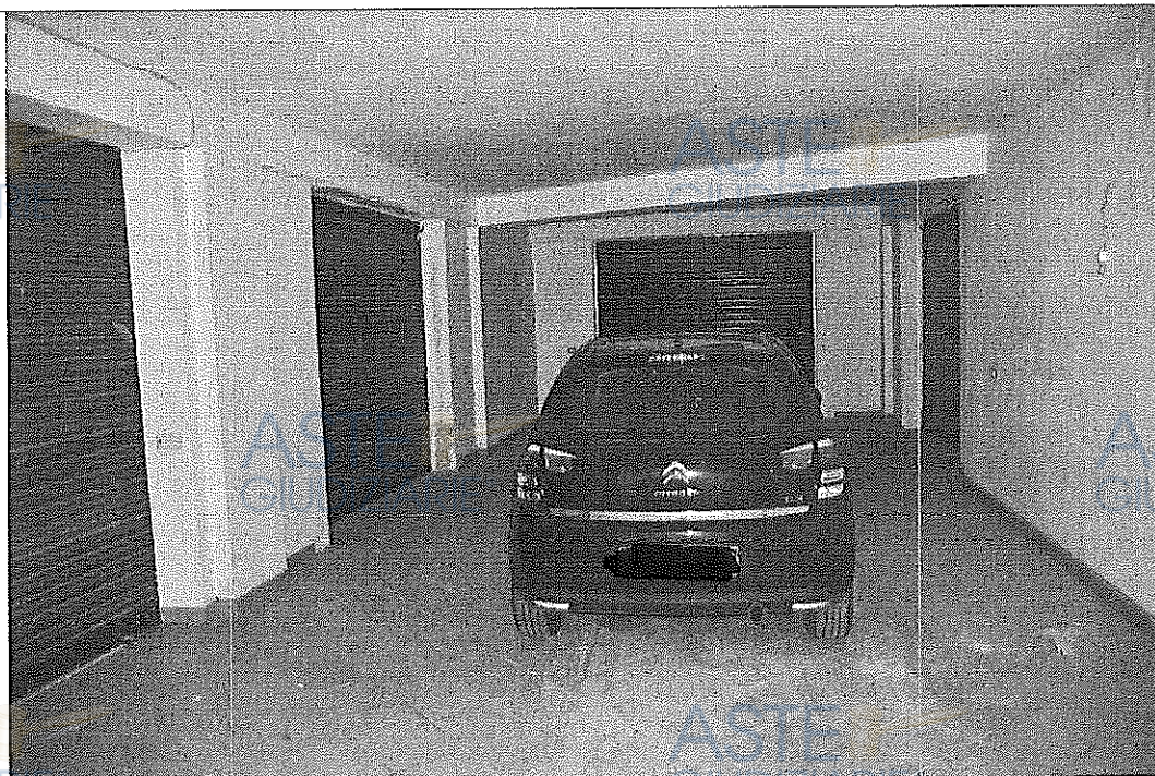
Foto n. 20 – Spazio di manovra comune a più particelle
