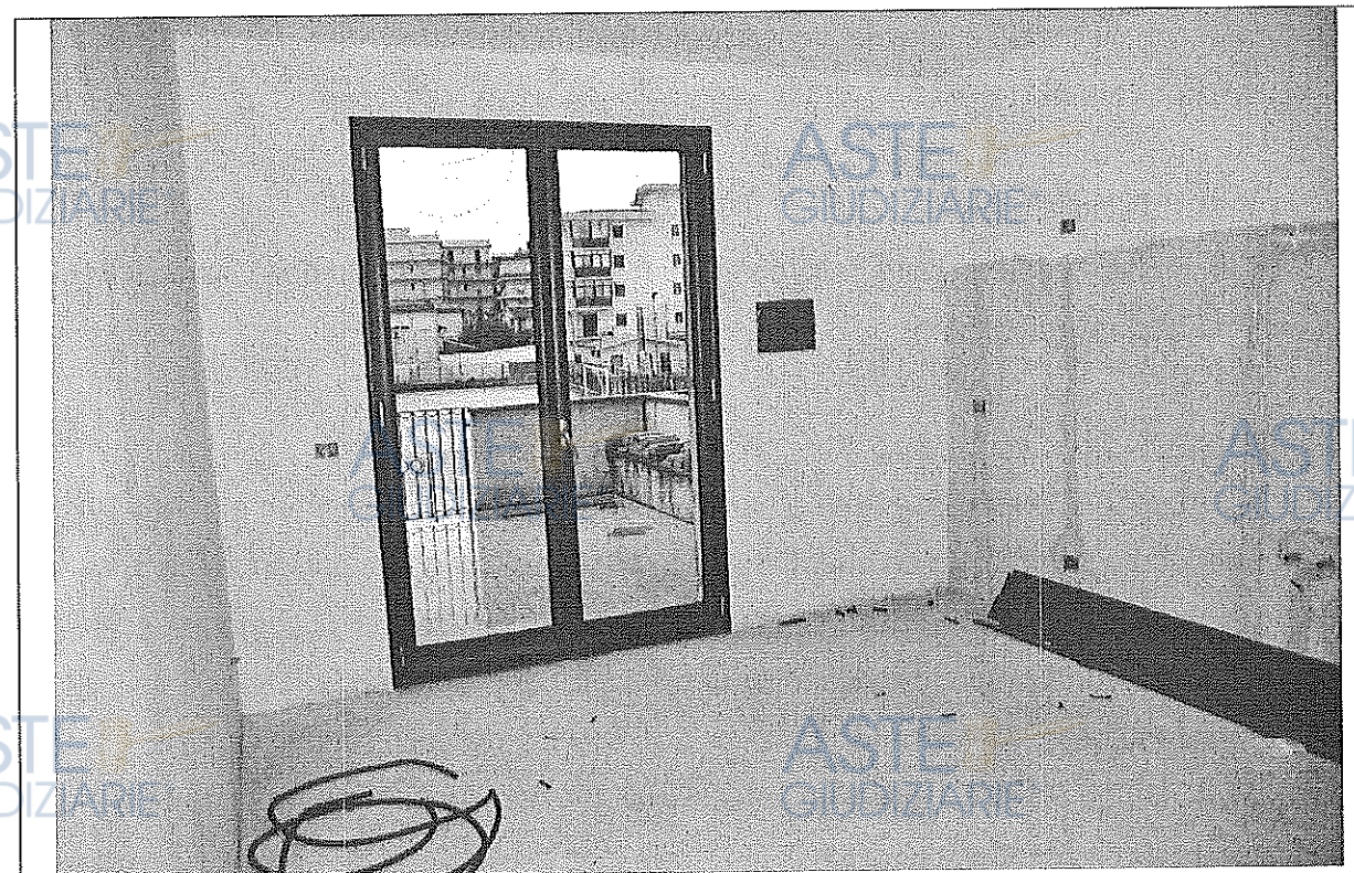
Foto n. 38 – Vano cucina ancora allo stato grezzo
