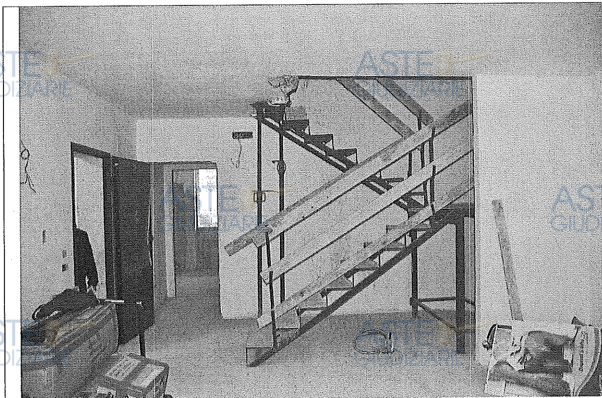
Foto n. 44 – Vista interna dell'appartamento
