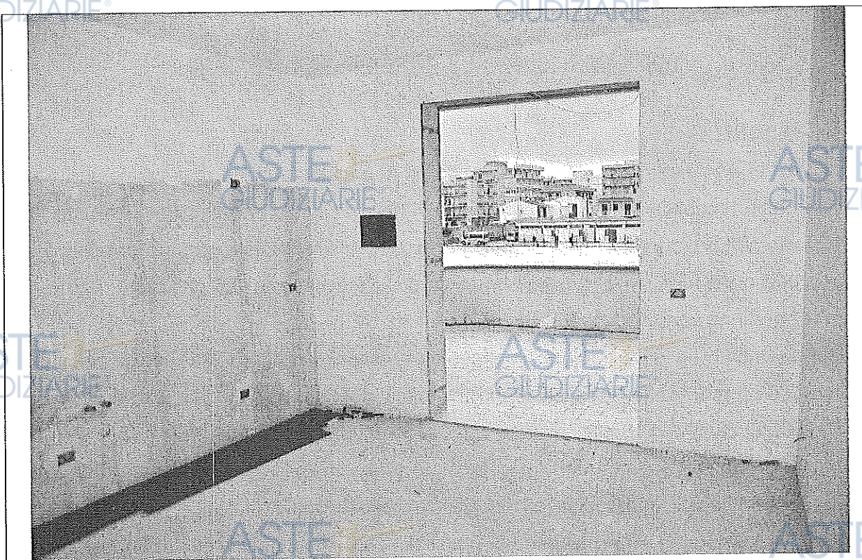
Foto n. 39 – Vista interna dell'appartamento
