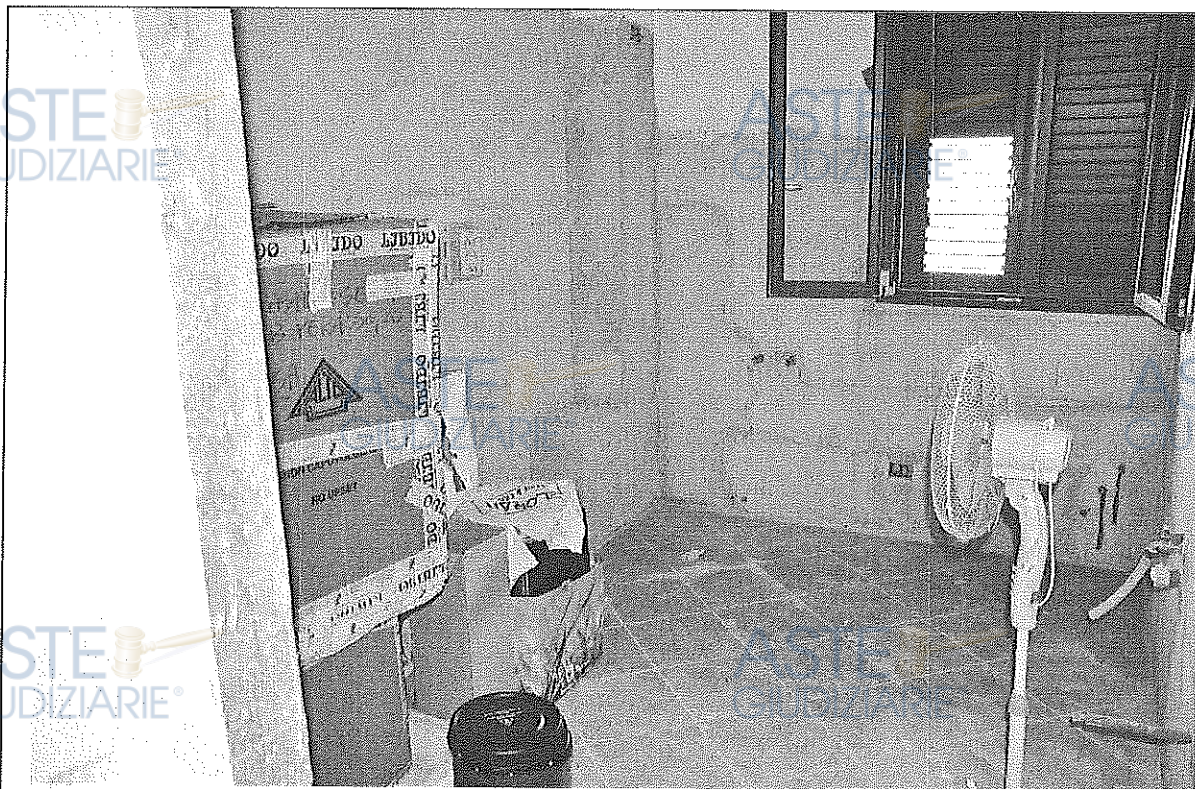
Foto n. 54 – servizio igienico piano secondo
