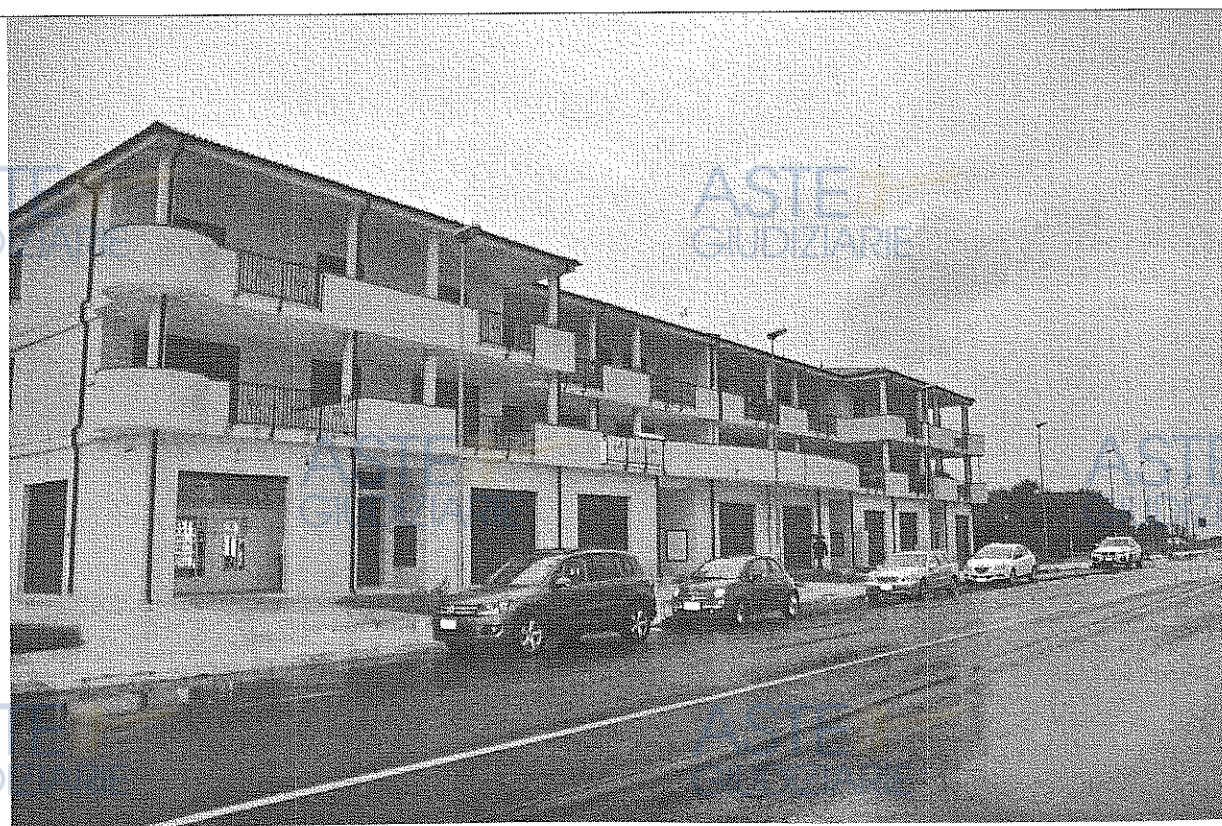
FOTO N.1 – Prospetto dell'edificio lato est
