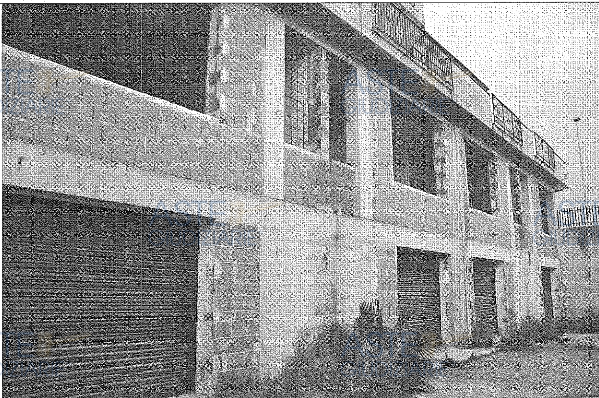
FOTO N.3 – Prospetto dell'edificio lato ovest
