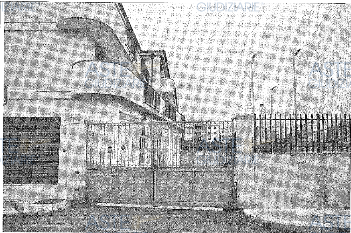
FOTO N.4 – Prospetto dell'edificio lato ovest
