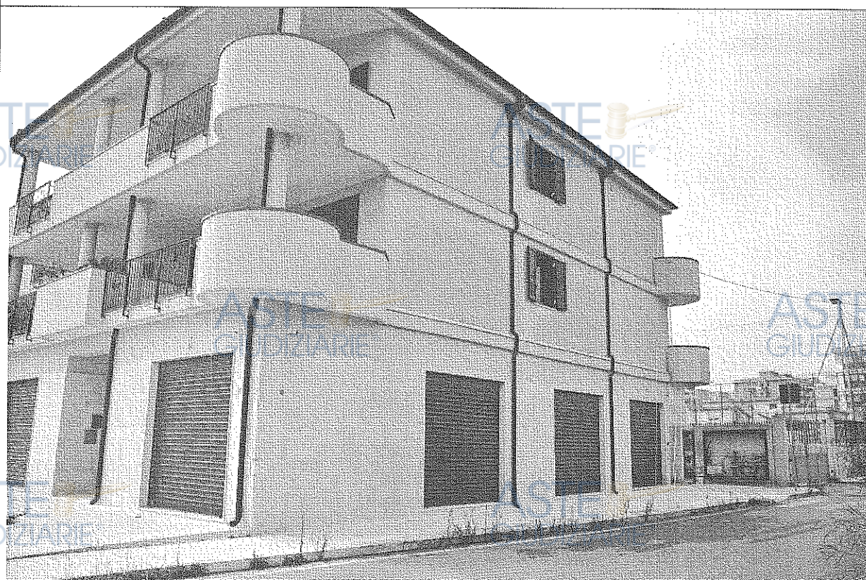
FOTO N.5 – Prospetto dell'edificio lato nord
