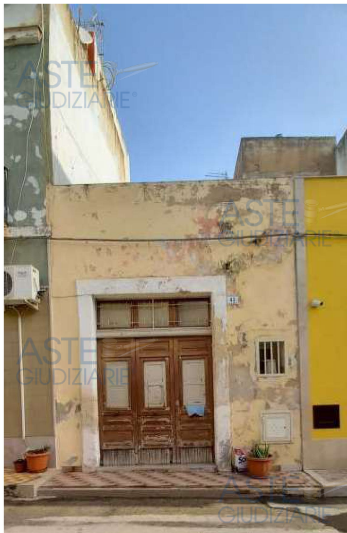
Foto 3 – Immobile “1A” – Prospetto di via De Amicis
