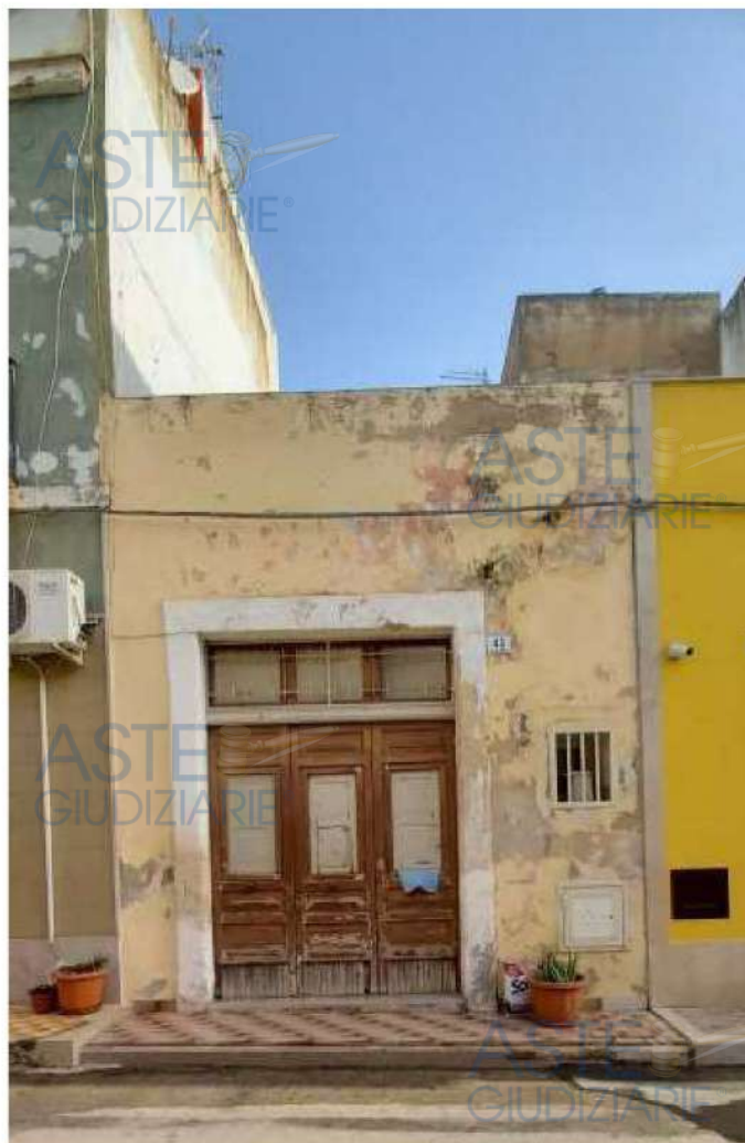
Foto 3 – Immobile “1A” – Prospetto di via De Amicis
