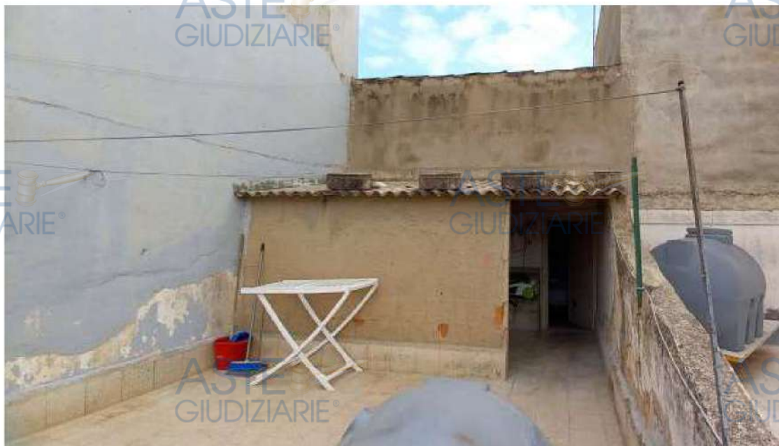
Foto 12 – Immobile “1A” – Terrazza a I P
