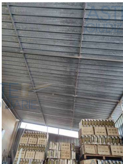
Foto 22,23, 25 Locale servizi igienici ed area esterna coperta
