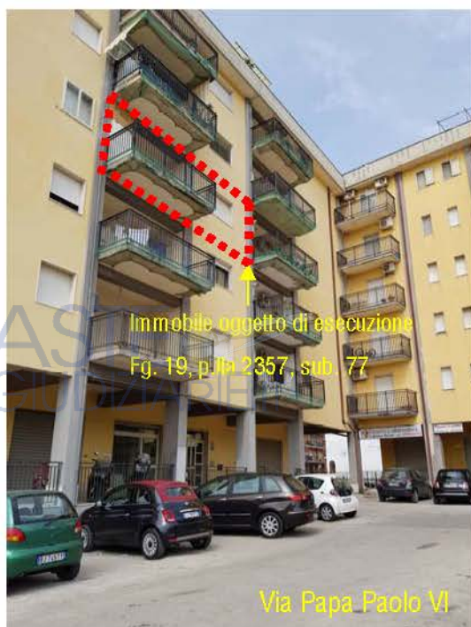
Vista dell'edificio su Via Papa Paolo VI
