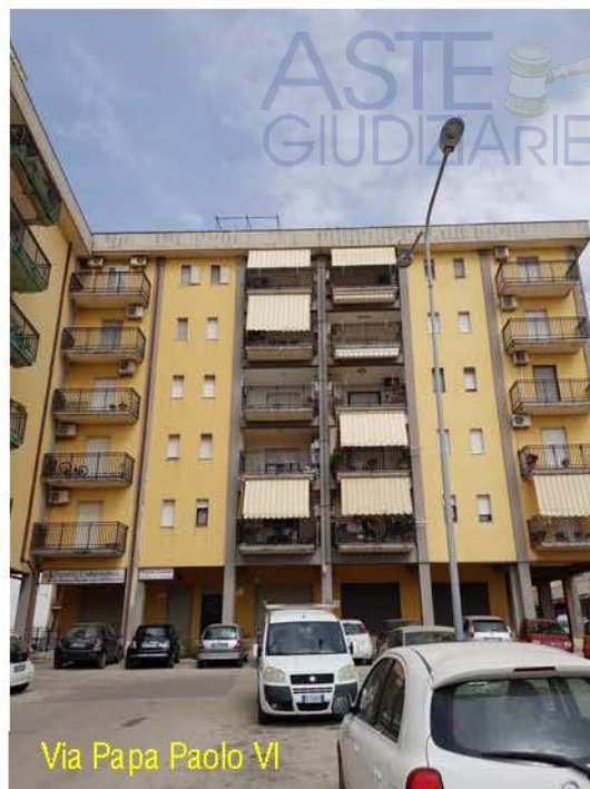
Vista dell'edificio su Via Papa Paolo VI
