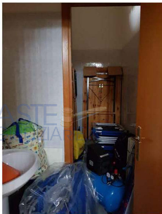
Vista del servizio igienico (aWc e Wc)
