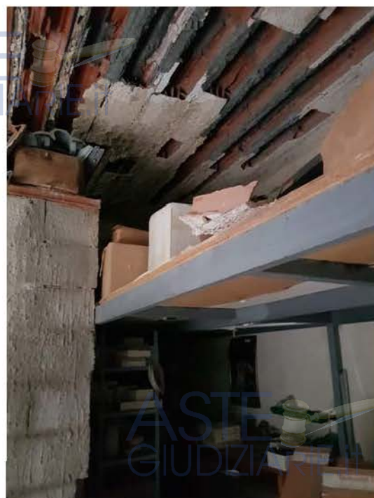
Vista del solaio del deposito (D1)
