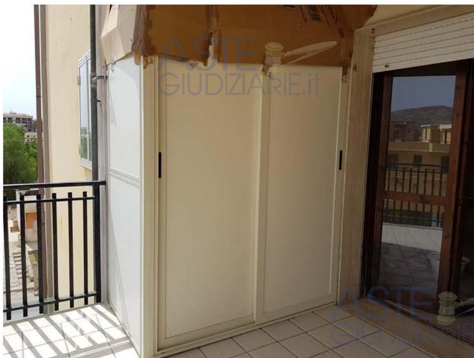
Vista del balcone (B)
