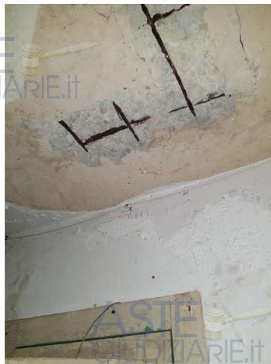
Vista della copertura del servizio igienico (Wc)
