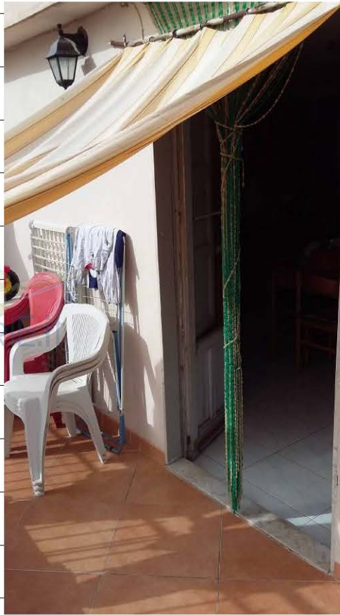
Foto 16 - LOTTO A_Porta di collegamento cucina terrazzo (Piano quarto)
