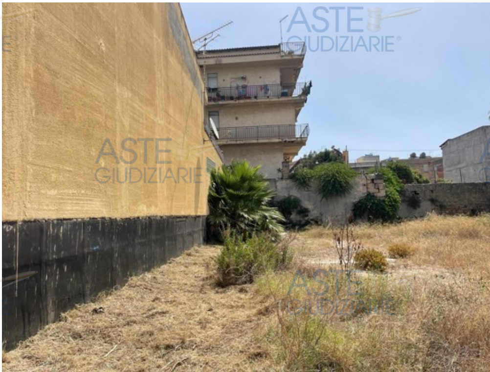
Fotografia C.11 - Carlentini-Foglio 16 p.lla 2331-2334-Terreno-Confini ovest-nord
