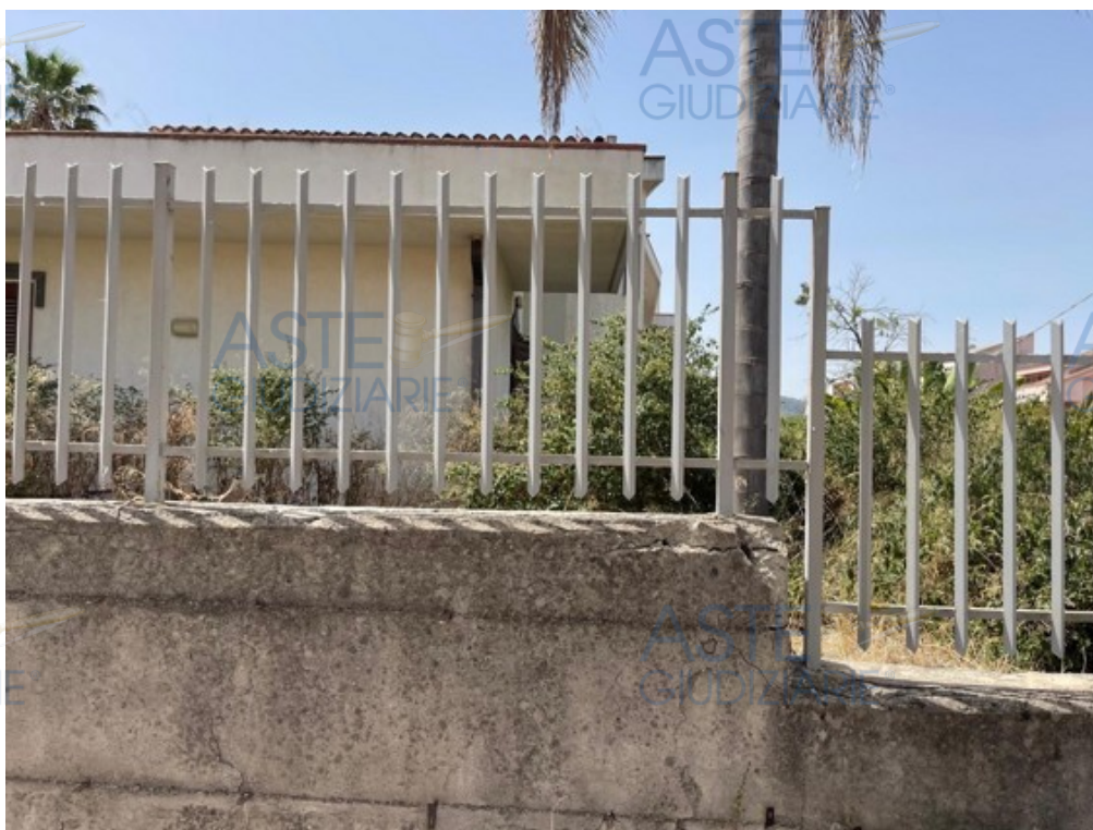
Fotografia C.9 - Carlentini-Foglio 16 p.la 2331-Terreno-Confini est
