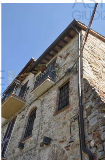
Particolare facciata esterna
